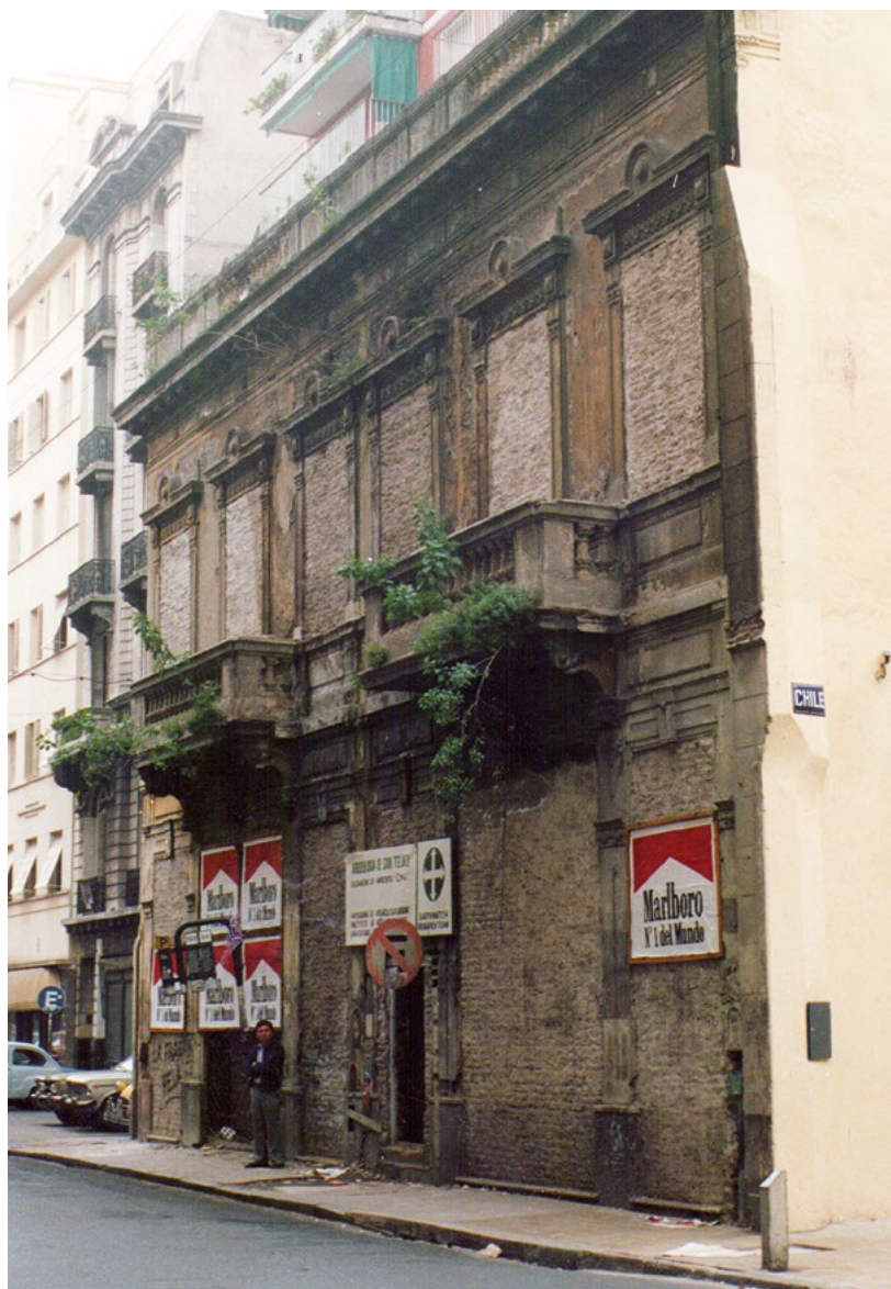
Fachada deteriorada de la antigua Imprenta Coni en Perú 680.
