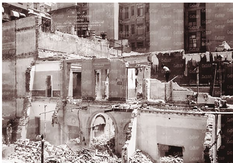
Fotografía de 1940 durante la demolición de la imprenta; se alcanza a ver parte de su interior y el patio principal.
