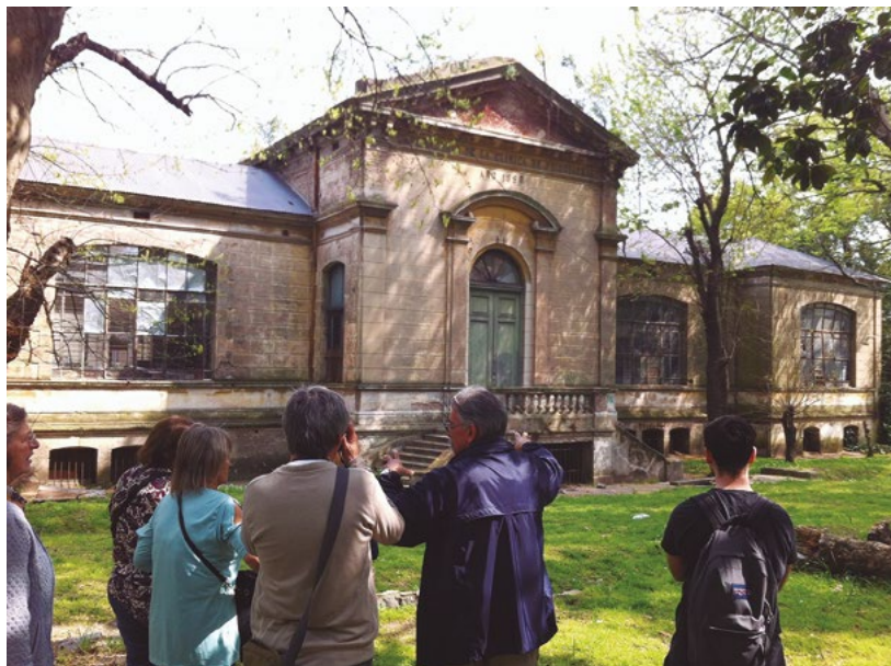
Edificio del Laboratorio de la Clínica de Psiquiatría durante una visita guiada del programa Los Barrios abren sus Puertas.
