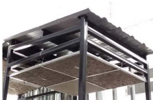
Fig. 8. Placas sujetas a estructura metálica
