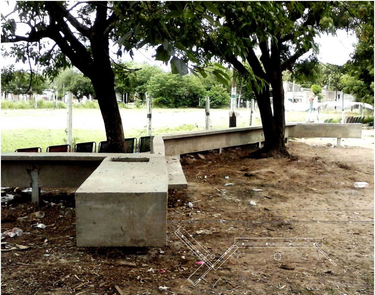
Fig. 3. Obra en su última etapa de ejecución del hormigón armado con agregados plásticos.
