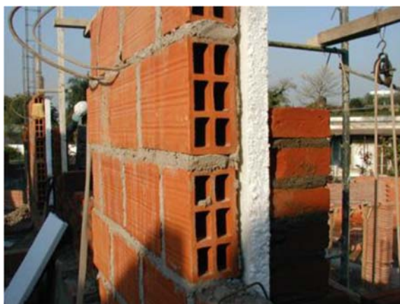
Fig. 1. Detalle de sector de pared doble, de ladrillo visto. Fuente: Fotografía de los autores.
