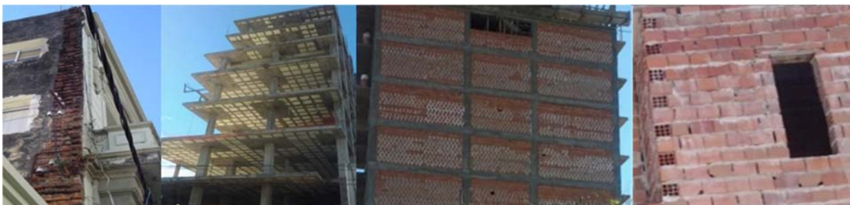
Fig. 4: Edificios en Altura en Argentina: hasta 1960 perímetros portantes macizos (izquierda); Desde 1970, con esqueletos estructurales; Desde 1980 con cerramientos de ladrillos huecos y losas alivianadas (centro), bajo acciones climáticas naturales: temperatura del aire y viento. Cerramientos constructivos perimetrales (derecha), sin sellado de las juntas verticales de los mampuestos huecos, quedando secciones transversales con aire y solamente cubiertas por los revoques superficiales. Fuente: JACOBO, 2016 y 2017.
