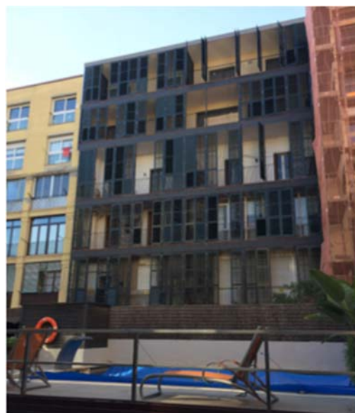
Fig. 9: Rambla Catalunya 82, fachada posterior renovada
