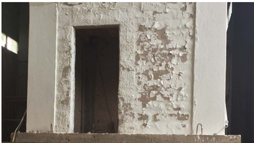
Foto 3: Refuerzo de mallas revocado.
