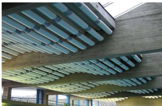
Fig. N° 2: falso techo acústico con cámara de aire en su interior y placa fonoabsorbente para la absorción acústica
