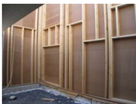
Fig.5 - Rigidización con revestimiento colaborante Fuente: Internet.
