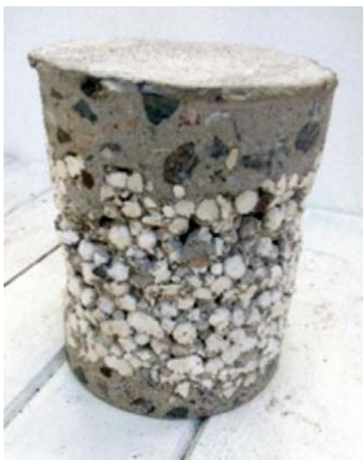
Fig. 1: Probeta extraída de panel PS120, obsérvese la sección de los hierros de refuerzo 4,2
