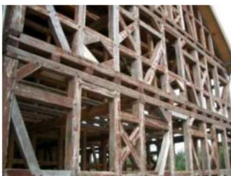
Fig. 4 - Rigidización con triangulación mediante diagonales. Fuente: Internet.
