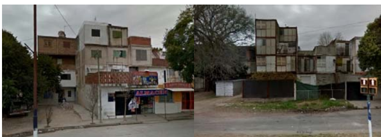
Fig. 1 y 2 estado actual del conjunto
