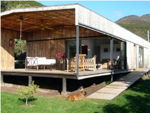
Fig. 8 - Vivienda realizada con madera de pallets Fuente: Internet
