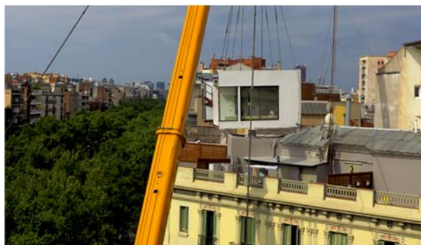
Fig 7: Gran Vía 504, montaje de módulos
