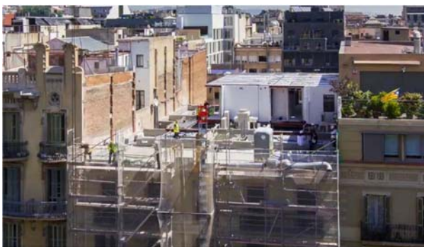
Fig. 6: Rambla Cataluña 82, montaje a medio ejecutar
