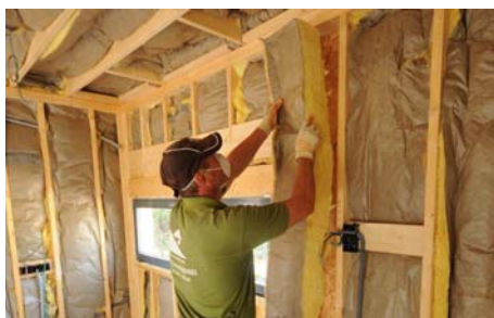
Fig. N° 9. Lana de vidrio con papel kraft que rellena el espacio entre montantes. Fuente : Internet
