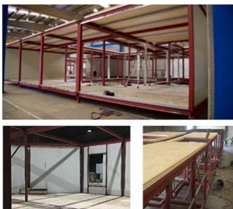
Fig. 4: Arquitectura industrializada, estructura y cerramientos
