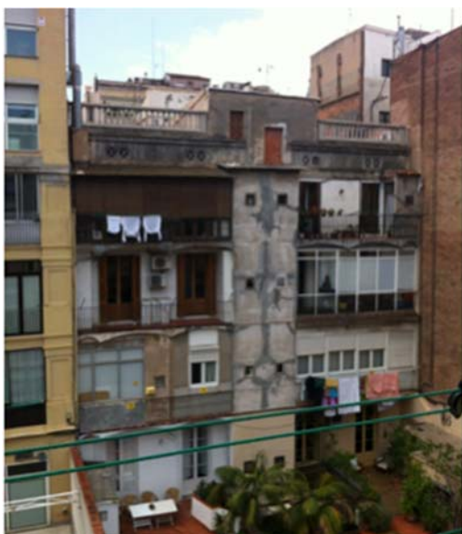
Fig. 8: Rambla Catalunya 82, fachada posterior sin intervenir
