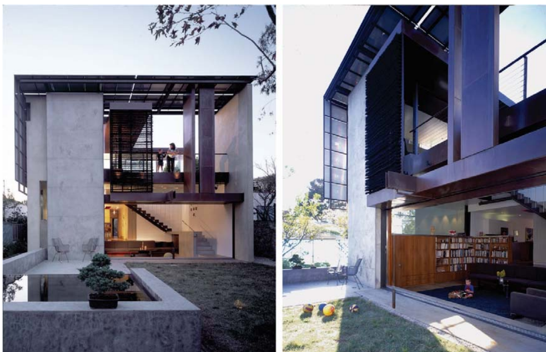
Fig. 4. Imagen exterior de la Solar Umbrella House en la que se observa el sobretecho fotovoltaico que la caracteriza. El gran paraguas solar colabora con la concreción de una gran fluidez entre espacio interior y exterior. Fuente:
