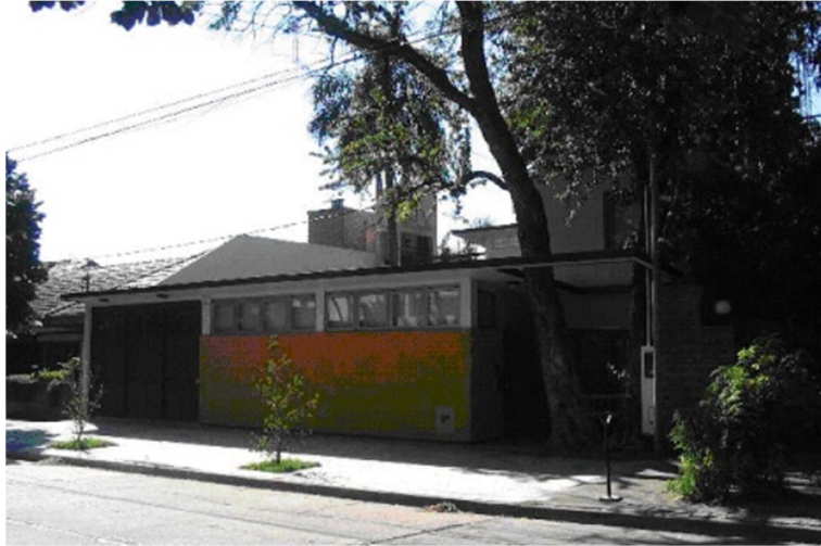
Figura 9.1: Vista exterior de la vivienda.
