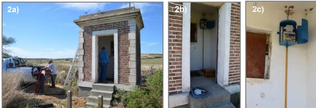
Figura 2. a) Estación de aforo de la PBA, b) vista del limnógrafo y c) abrigo antivandálico
