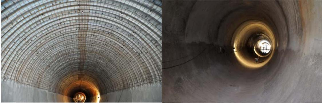
Figura 4. Túnel de hormigón armado por avenida 139, desde calle 531 hasta calle 37 (izquierday túnel de 4,3 m de diámetro (derecha) (Fuente: MlySP-PBA, 2015)
