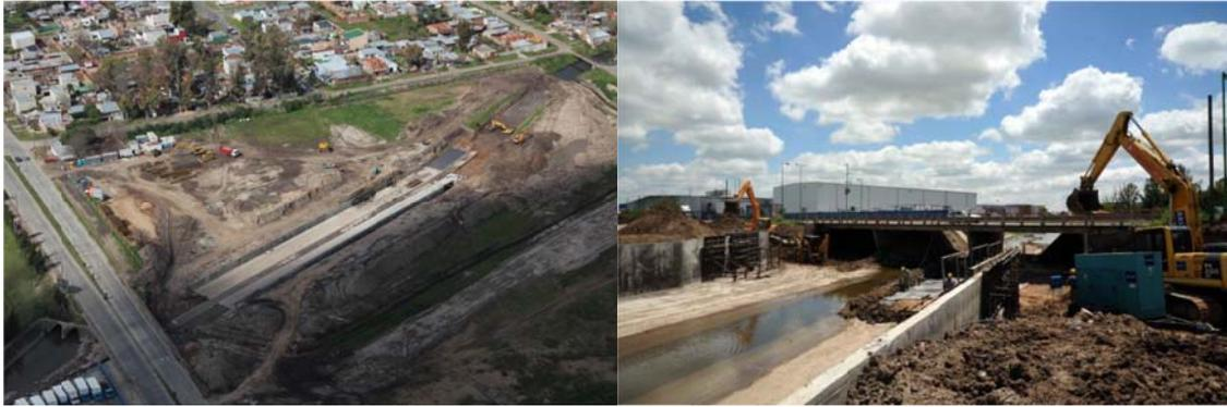
Figura 2. Vista aérea sección rectangular de hormigón armado y obra de canalización en construcción (Fuente: MlySP-PBA, 2015)
