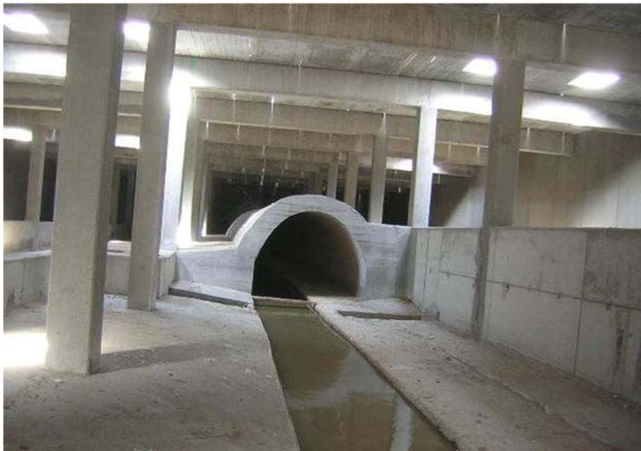
Figura 10. Tanque de tormenta en Burjassot, Valencia (*Fuente MMA 2002*).
