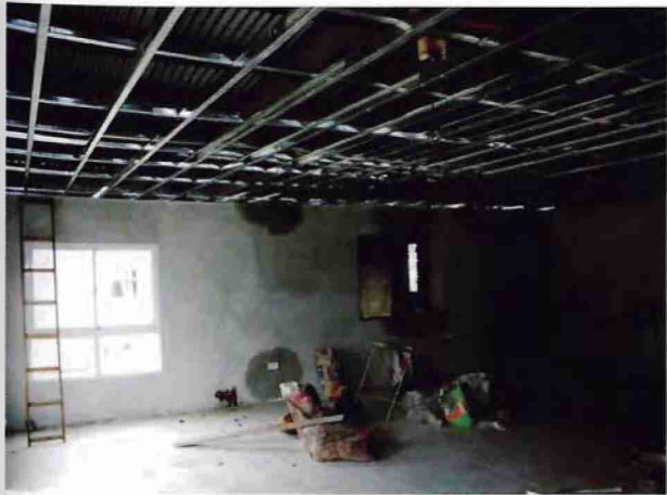
OBRA DEL SALÓN BLANCO MUNICIPAL
