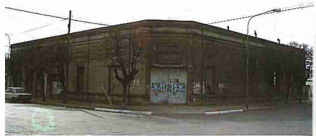
ANTIGUO EDIFICIO USINA
