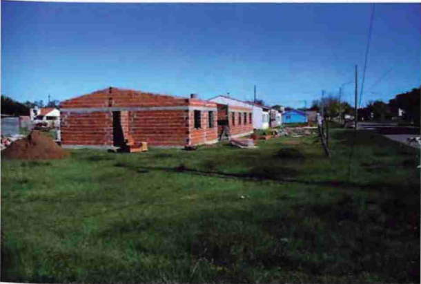
CONSTRUCCIÓN DE VIVIENDAS
