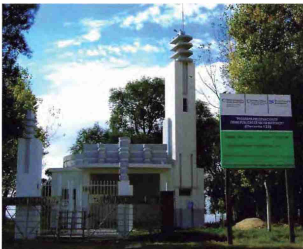
MATADERO MUNICIPAL EN OBRA
