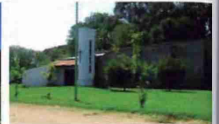
IGLESIA DE LA LOCALIDAD DE ING. THOMPSON
