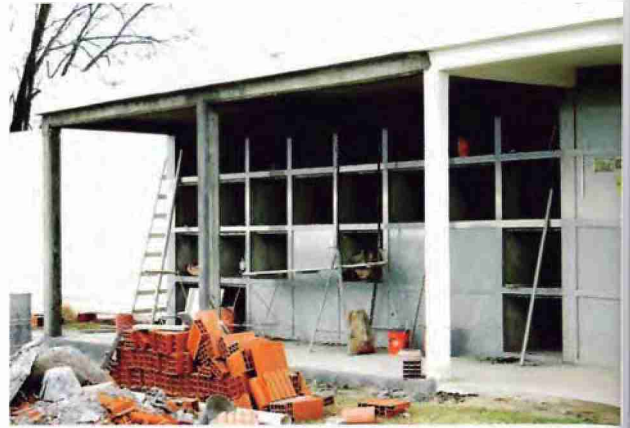
OBRA DEL CEMENTERIO
