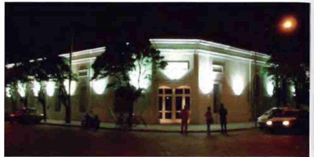
EDIFICIO USINA - CENTRO CULTURAL LA VIEJA USINA
