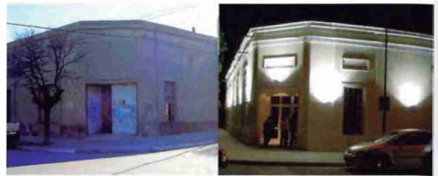
EDIFICIO USINA EN OBRA
