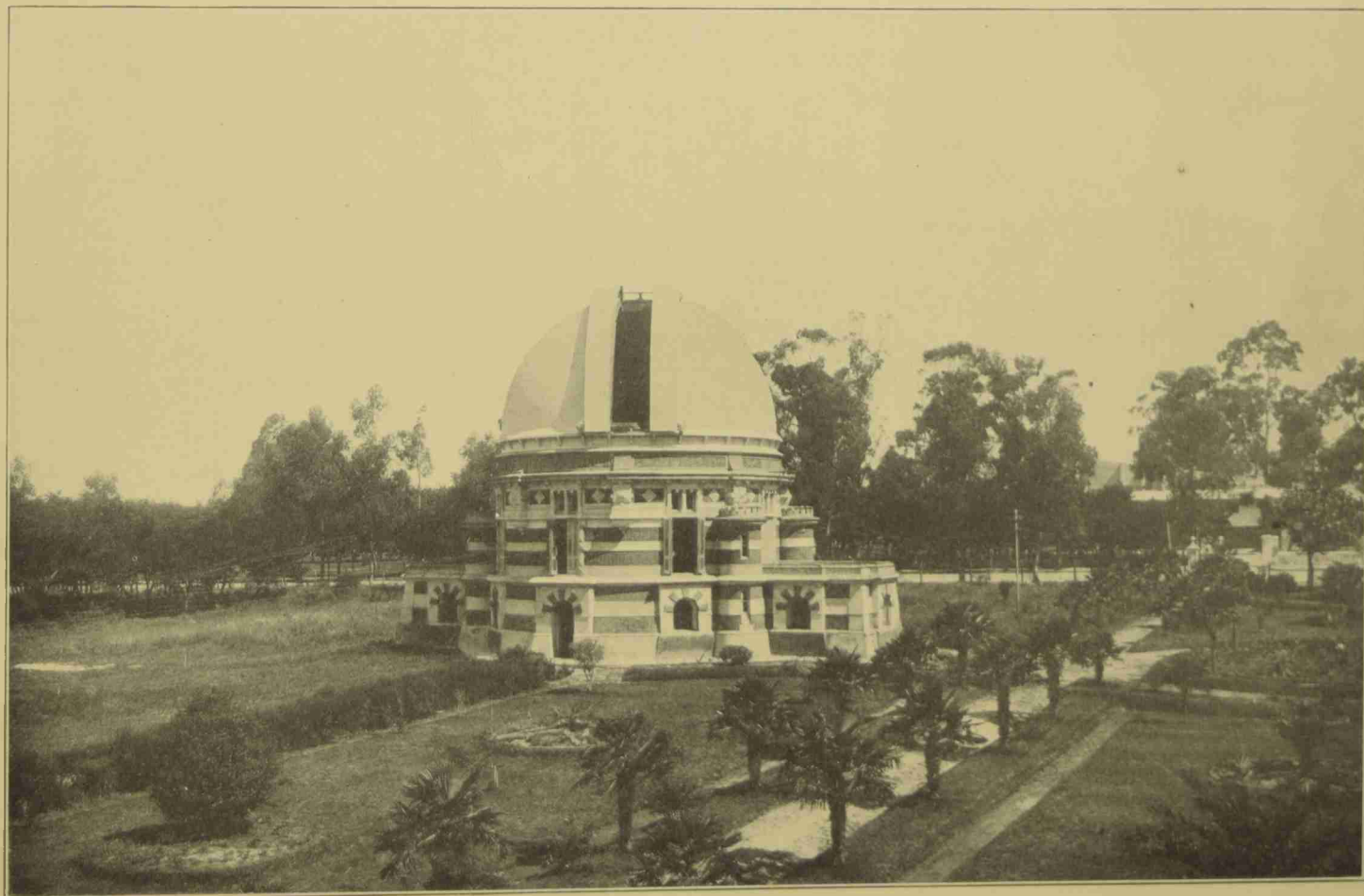
EL EDIFICIO DEL TELESCOPIO REFRACTOR GAUTIER
