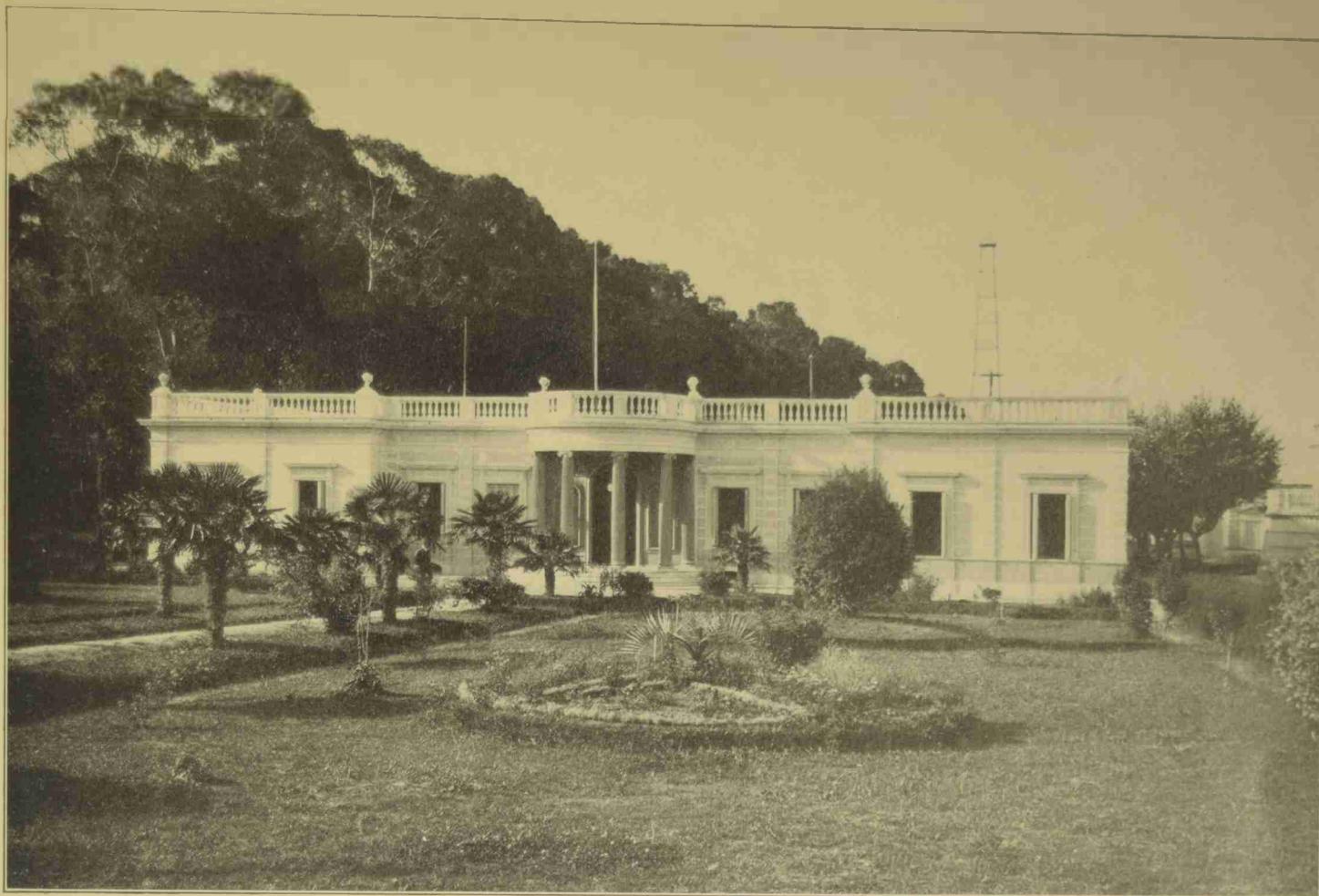
EL EDIFICIO PRINCIPAL—LA FACHADA DEL SUR
