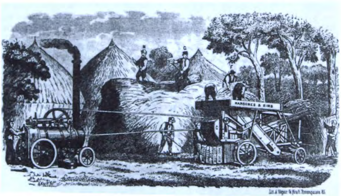
Fig. 6 Trilla de trigo con una de las trilladoras más difundidas, la Ransomes & Sims. A la izquierda el motor de vapor y el maquinista, sobre la parva los horquilleros acercan las gavillas a los embocadores parados en la plataforma superior de la trilladora. A la izquierda de la trilladora el bolsero atiende el llenado de las bolsas y a su lado un horquillero recoge gavillas caídas. A la derecha, otro operario acomoda la paja trillada. Las trilladoras se difundieron rápidamente cuando los motores se adaptaron al uso de la paja como combustible.
