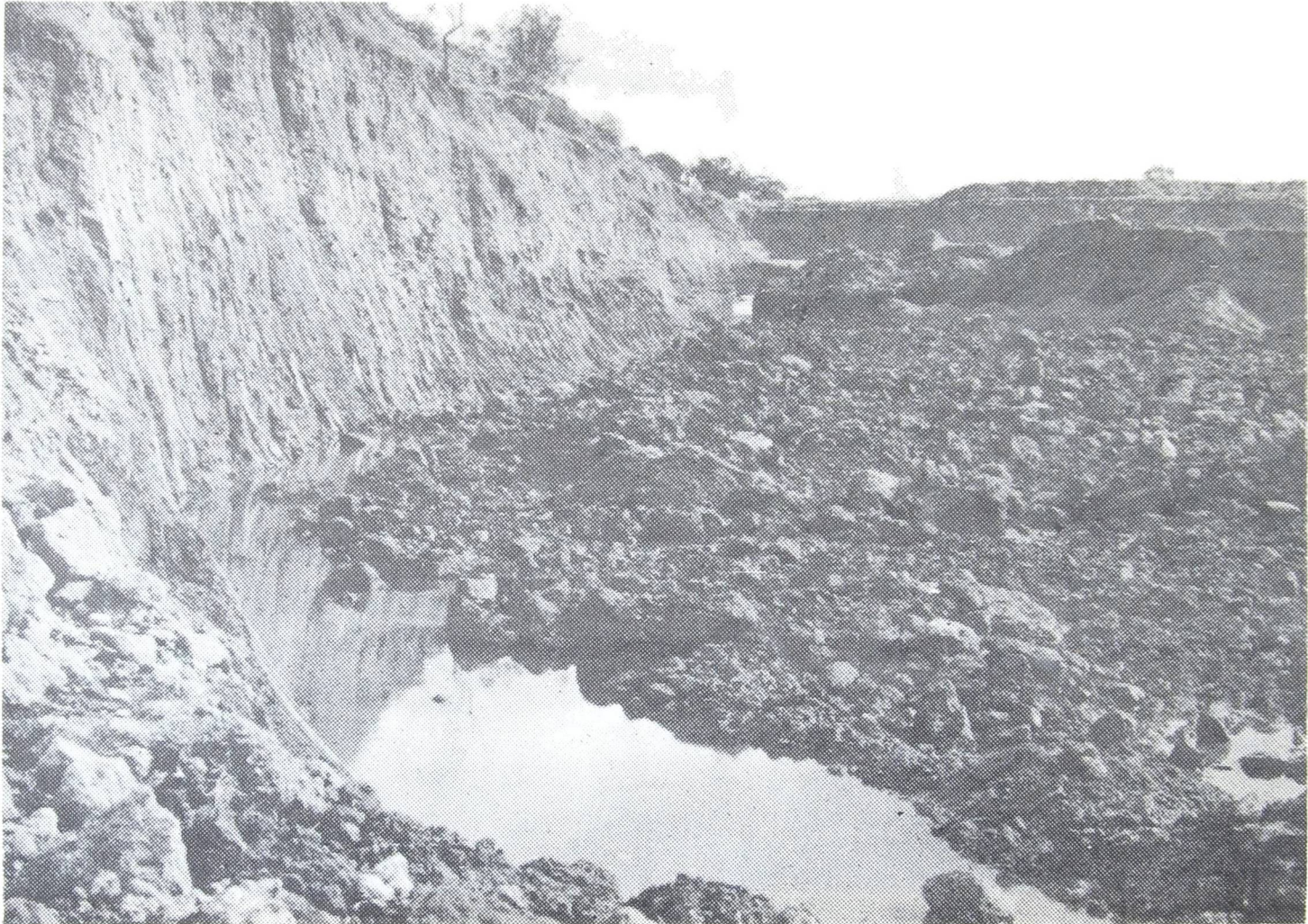
Imagen 3: En esta cantera de aproximadamente ocho metros de profundidad se observa un talud de casi 90° que llega al límite de la propiedad y un canal de desagüe interno cuya circulación tiene lugar con la ayuda de bombas de extracción de agua.
