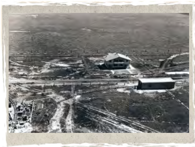
Figura 18. Pipinas antes de la instalación de Corcemar. ©2017 Google.
