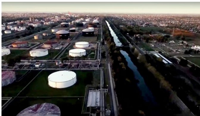
Figuras 9 y 10. Vistas aérea de la Refinería YPF y el Polo Petroquímico de Ensenada. Fotos: Tomás Canevari, 2017
