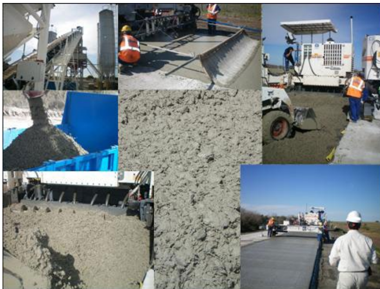
Figura 110. Empleo de macrofibras sintéticas en un whitetopping adherido empleado para la reparación y refuerzo de la ruta 24 en la República Oriental del Uruguay. Elaboración propia.
