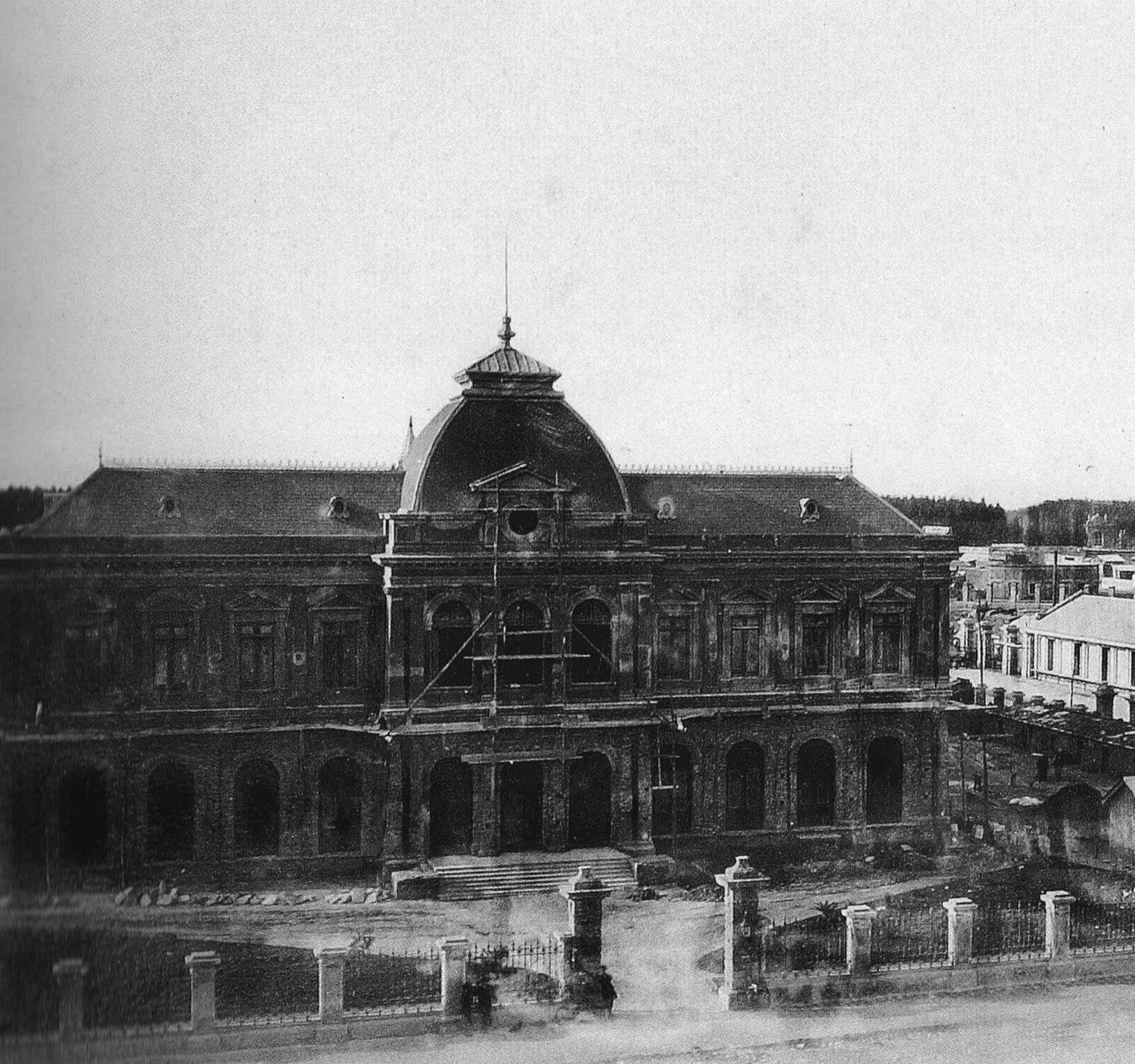
Construcción del Banco Hipotecario, actual edificio de la Presidencia de la UNLP (1882).
