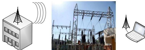
Figura 1. Transmisión de Señal con punto de prueba cercano a subestación de energía eléctrica
