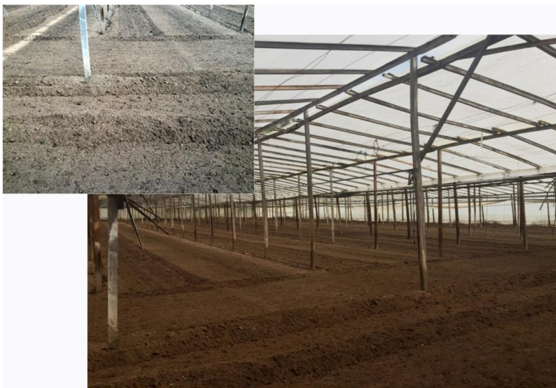
Imagen 17. Vista general del invernáculo preparado para la plantación de tomate, con detalle de lomos con el suelo pulverizado
