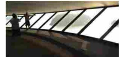
Proteção solar de alta e média intensidade. Entre 6:0 h. Y 8:00h. Y 16:00h. Y 18:00h., se forma uma mancha solar na parte interna
