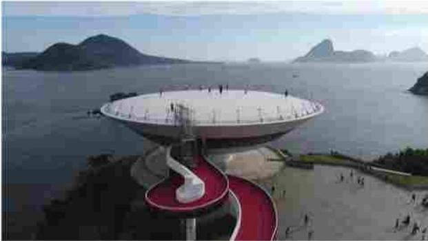
El edificio cuenta solo con un pilar cónico y, encima del él, una gran cúpula se expande como un cáliz. A su vez, evita el ángulo frontal de incidencia del sol, la homogénea distribución de la luz en su fachada dispuestas oblicuamente para que los rayos de luz produzcan fuertes contrastes de luz y sombra.
