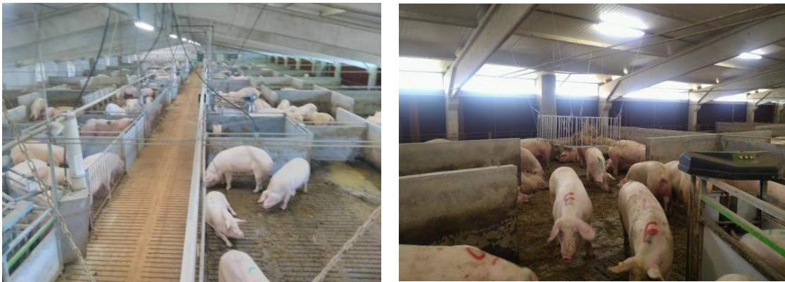
Figura 7 y 8. Sistema de galpones de gestación grupal.
