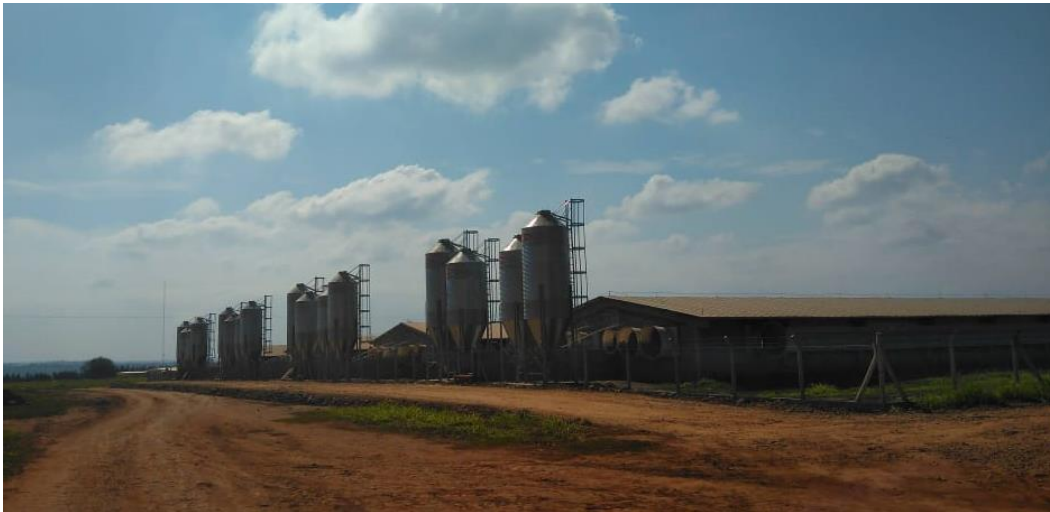
Figura 2. Sistema de galpones con cerco perimetral y silos de almacenamiento de alimento.
