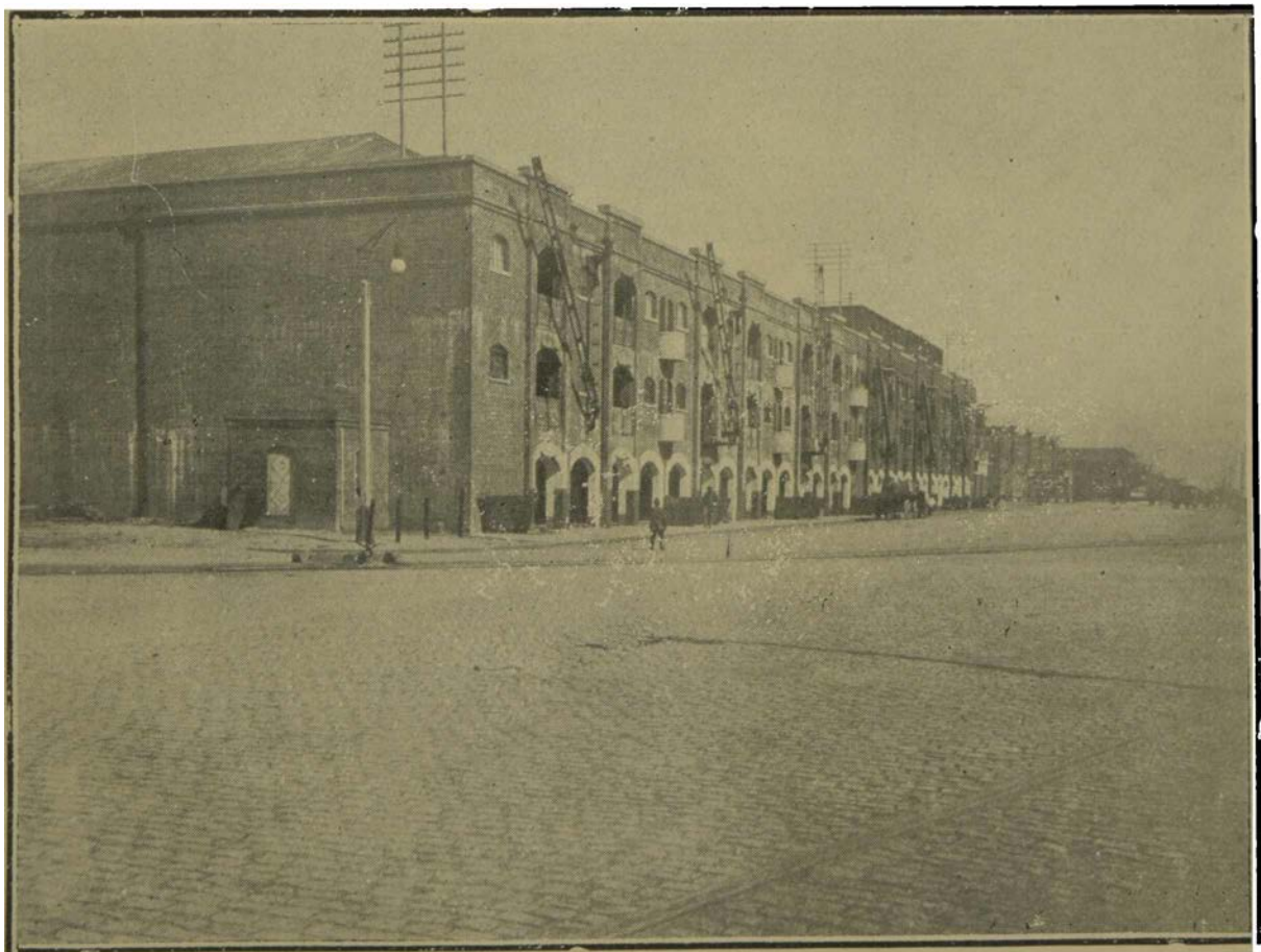
Depósitos del Dique 2.
