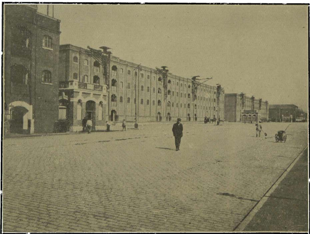
Depósitos del Dique 1.
