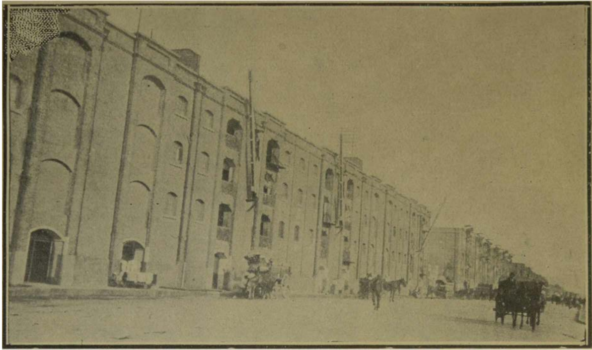
Depósitos del Dique 4.
