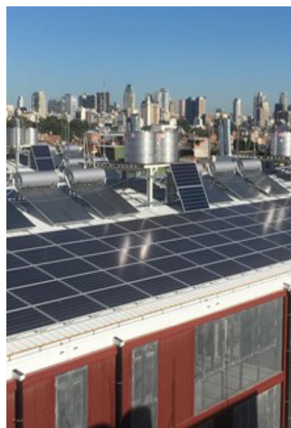
FIGURA 9. A LA IZQUIERDA: SISTEMA SOLAR TÉRMICO DE LOS PRIMEROS EDIFICIOS. ESQUEMA SPLIT CON RECIRCULACIÓN Y PRESURIZADOS: ESQUEMA DE ALTA EFICIENCIA. A LA DERECHA, LOS IMPLEMENTADOS EN LA MAYORÍA DE LOS EDIFICIOS (SECTO YPF), CON ESQUEMA COMPACTO TERMOSIFÓNICO, ATMOSFÉRICO: MÁS SIMPLE Y ROBUSTO.
