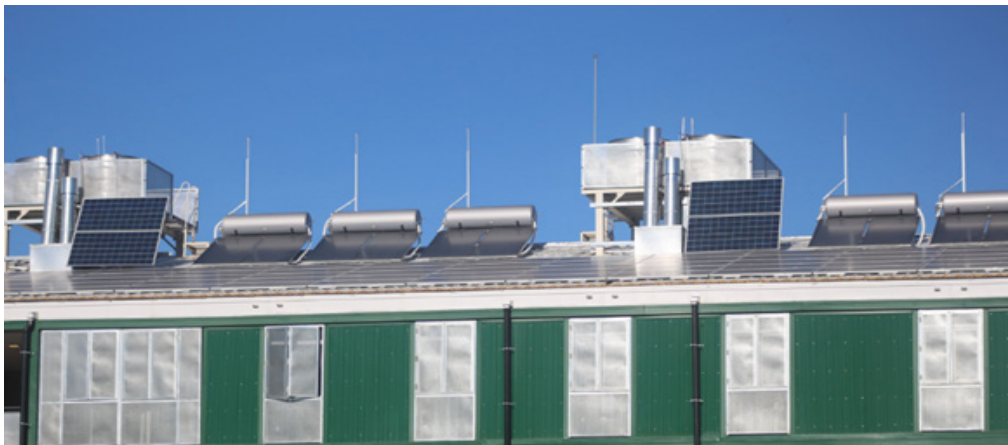
FIGURA 8. NUEVAS VIVIENDAS DE BARRIO 31: SE OBSERVAN LOS TERMOTANQUES SOLARES Y LOS MÓDULOS QUE ALIMENTAN EL SISTEMA DE BOMBEO (COLOCADOS DE MANERA CASI VERTICAL)
