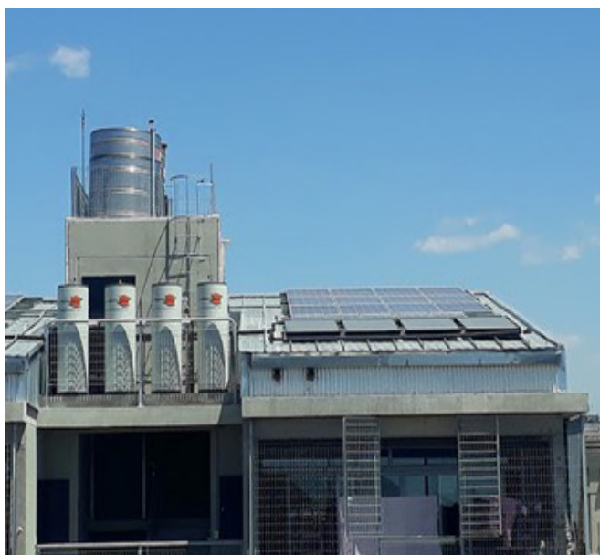
FIGURA 9. A LA IZQUIERDA: SISTEMA SOLAR TÉRMICO DE LOS PRIMEROS EDIFICIOS. ESQUEMA SPLIT CON RECIRCULACIÓN Y PRESURIZADOS: ESQUEMA DE ALTA EFICIENCIA. A LA DERECHA, LOS IMPLEMENTADOS EN LA MAYORÍA DE LOS EDIFICIOS (SECTO YPF), CON ESQUEMA COMPACTO TERMOSIFÓNICO, ATMOSFÉRICO: MÁS SIMPLE Y ROBUSTO.
