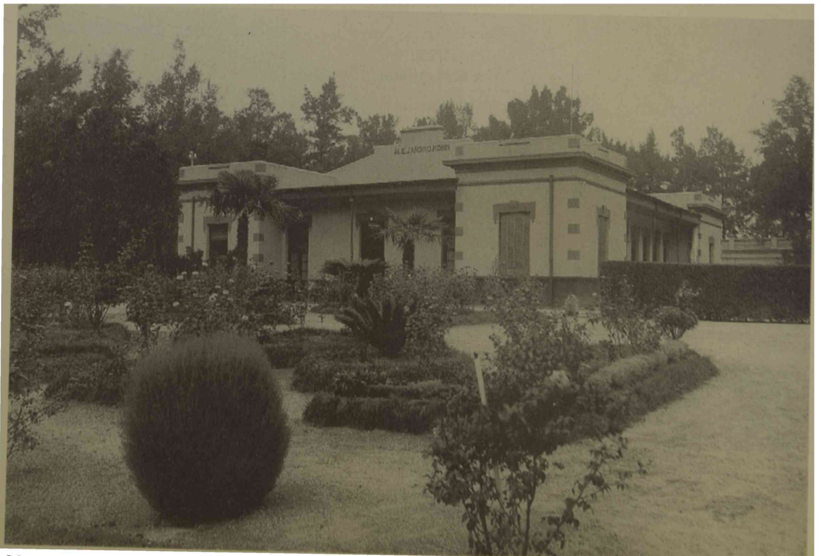
Vista de la Casa del Director del Hospital en 1905
