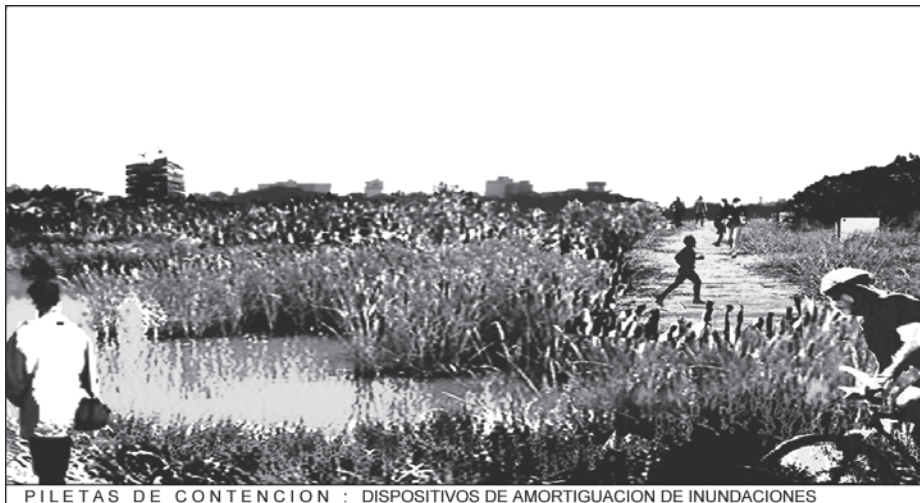
Figura 13: Piletas de contención de crecidas: dispositivos de amortiguación de inundaciones.
