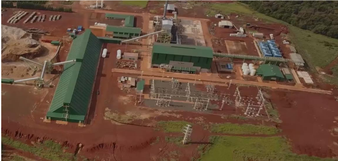
Figura 6.24. Planta de producción de energía eléctrica a base de biomasa (Virasoro, Corrientes). Fuente: FRESA (2020) 25 .
