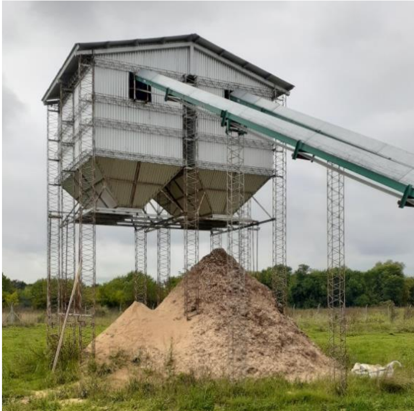
Figura 3.35. Almacenamiento de aserrín (pila izquierda) y chips (pila derecha)-CTM. Fuente propia (2021).
