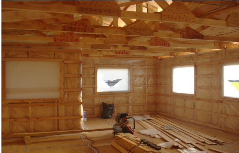
Figura 1.16. Estructura de vivienda realizada con madera de Salix spp. -LIMAD. Fuente: propia (2017).
