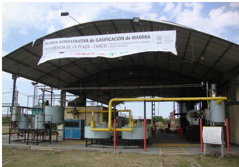
Figura 6.33. Planta de gasificación de residuos madereros (Presidencia de La Plaza, Chaco). Fuente: propia (viaje de estudio Ing. Ftal., 2015).
