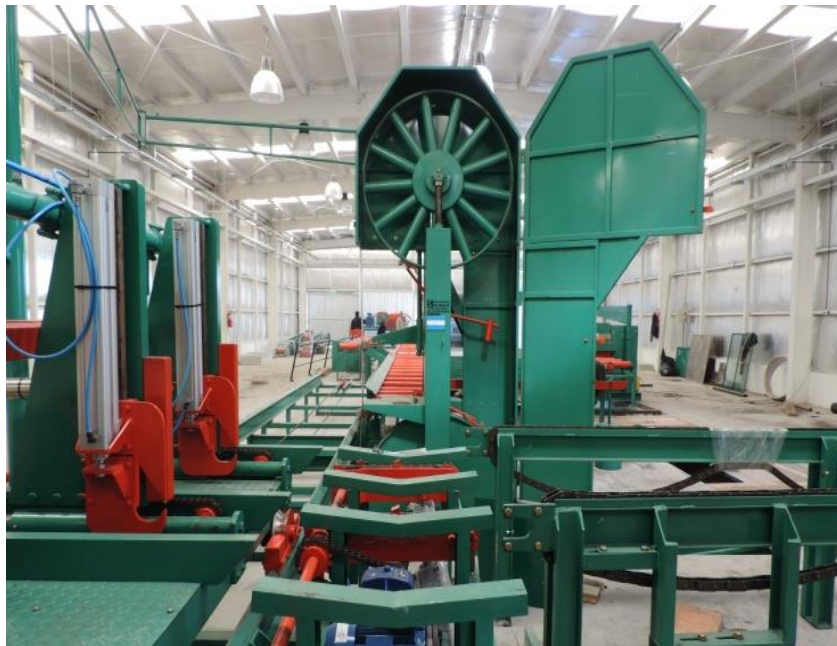
Figura 2.2. Aserradero permanente-CTM. Fuente: propia (2018).
