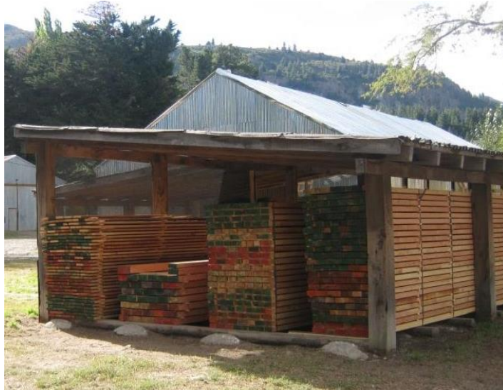
Figura 5.9. Secado natural bajo tinglado-INTA (Trevelin, Chubut). Fuente: propia (pasantía estudiantil, 2015).
