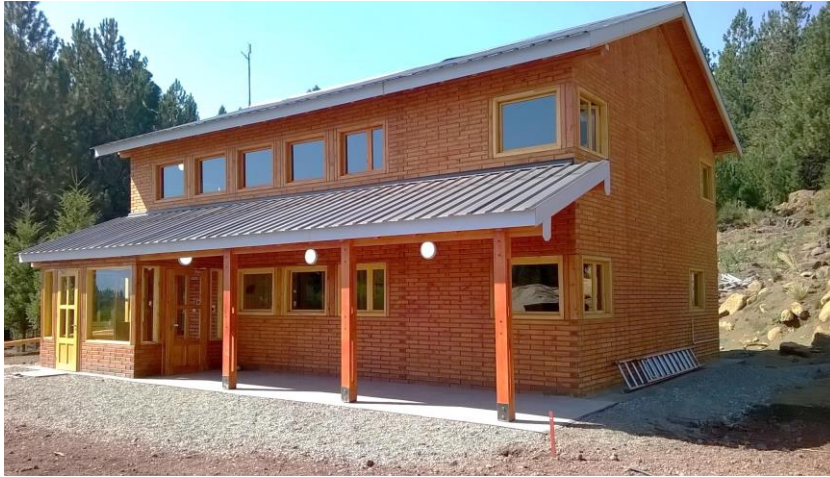
Figura 1.7. Construcción con BME (Abra Ancha, Neuquén). Fuente: propia (viaje de estudios Ing. Ftal., 2018).
