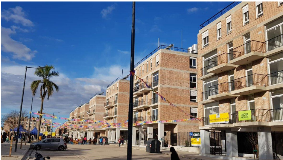
Figura 3: Bloques habitacionales de la reurbanización de Rodrigo Bueno
