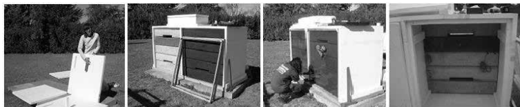
Figura 39. Montaje de los dos BOX (recintos estancos), las vidrieras y la instalación completa de los MAC, con los sensores destinados a medir las temperaturas internas y externas.
