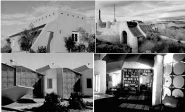
Figura 10. Ejemplos de viviendas pasivas, con ganancia directa, muros de adobe, y con muros acumuladores en agua como los de la Casas solares de Corrales house I: Casa solar de Zome, de Steve Baer en Nuevo México, 1970- 1972.
