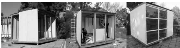
Figura 64. Módulo de ensayos en sus etapas de construcción. (J. Jodra, 2021)
