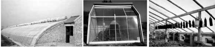
Figura 78. Invernadero solar pasivo con muros sólidos de adobe, China (Fuente: Li-Hong et al., 2010); invernadero en vidrio con Colector solar interior, Tunes (Fuente: Bouadila et al., 2014a); e invernadero con acumulación térmica en botellas PET, Bolivia (Fuente: MDRyT de Bolivia, 2016).
