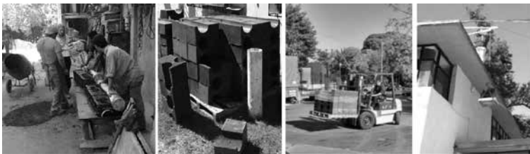
Figura 60. Fabricación seriada de los bloques en moldes metálicos y recepción de los bloques pre-moldeados.
