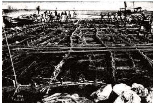
Construcción de enfajinados (foto en Carrique 1908).
