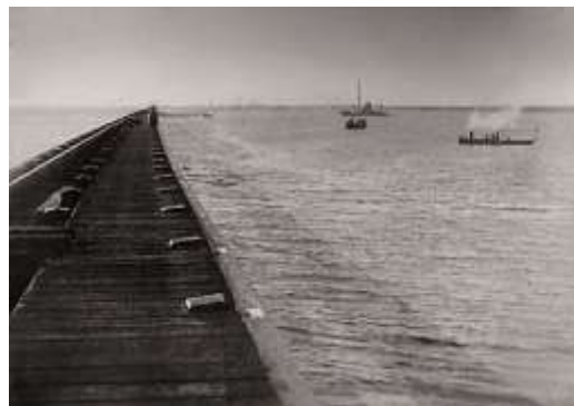
Fig. 29 Escollera de faginaje y Muelle de madera en las entradas de Puerto La Plata, 1888.
