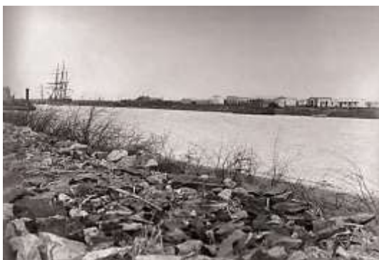
Fig. 29 Escollera de faginaje y Muelle de madera en las entradas de Puerto La Plata, 1888.
