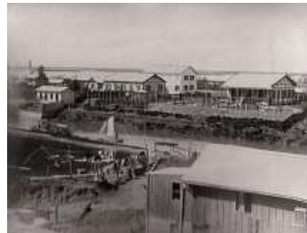
Fig. 27 Depósitos y Talleres en Puerto La Plata (plano 1886-fotos 2001-1888).
