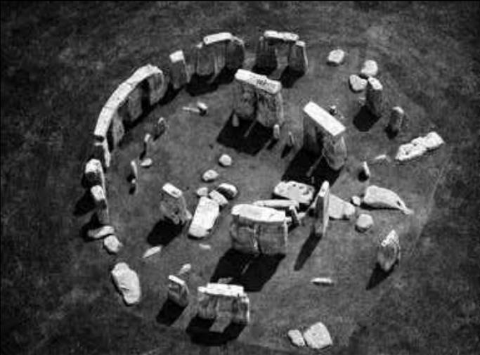
TRILITO: estructura que consta de dos grandes piedras verticales (postes) el apoyo a una tercera serie de piedra horizontalmente en la parte superior (dintel).
