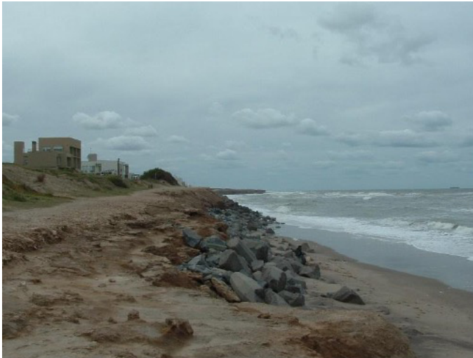
Figura 3 – Visual hacia el Este desde el perfil 5. Se aprecia la protección del acantilado y la pérdida de arena en playa distal y frontal. Elaboración propia.
