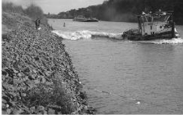
Ilustración 8 - Efecto del oleaje producido por embarcaciones sobre las costas. Fuente: Publicación del Bulletin N°88 of the Federal Waterways Engineering and Research Institute- Principles for the Design of Bank and Bottom Protection for Inland Waterways
