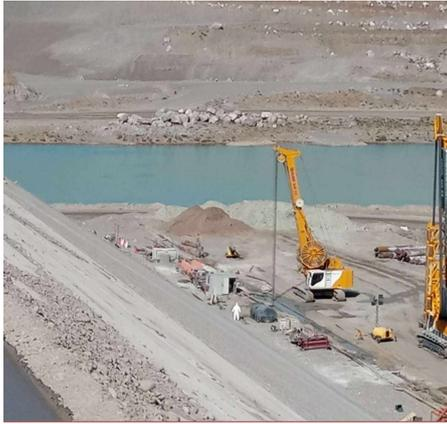
a. Talud húmedo y pantalla impermeabilización en construcción (margen izquierda)
