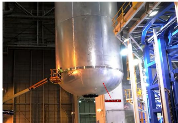
Figura 13. Disposición final de c/u 8 gajos soldados por fricción.
