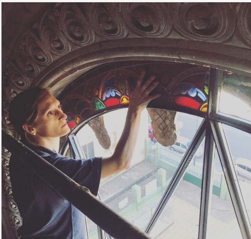
Montaje de los primeros paneles ya restaurados. Parroquia-Santuario Medalla Milagrosa.
