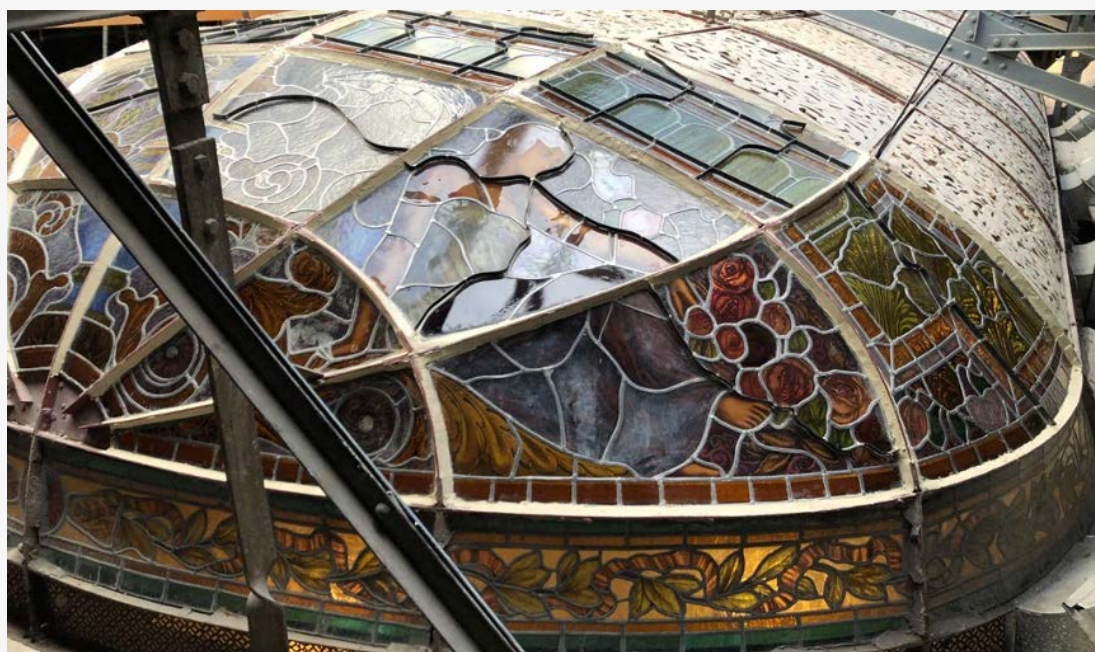
Antes y después de los trabajos de conservación, restauración y realización de los paneles ausentes. Confitería La Ideal, CABA.
