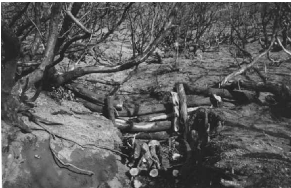
Figura 7.31. Tratamientos estructurales. Vista de frente de un dique de postes quemados (Año 2001).
