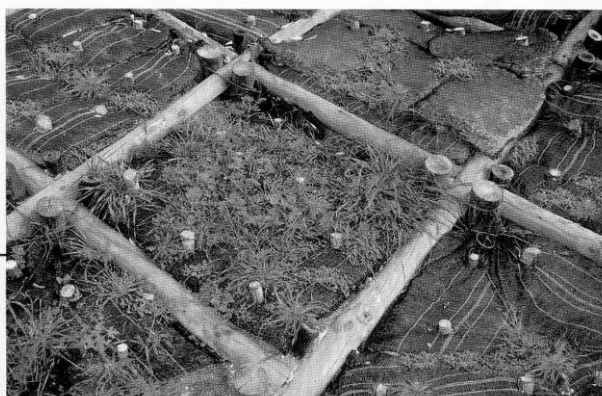
● Visión detallada de la fase de estabilización de la obra a través del desarrollo de pastos.
