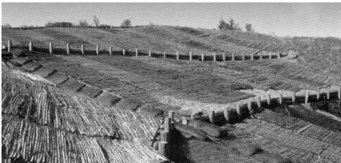
Figura 7.4. Obras longitudinales sobre laderas con palizadas, cubrimiento de suelo con encañado y direccionamiento de escurrimiento mediante embolsado.
