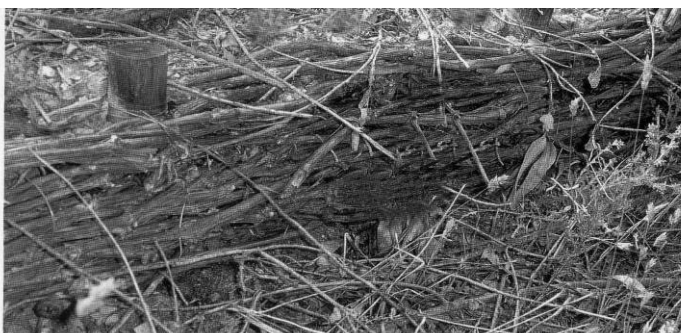
● Vista detallada de tratamiento lineal con fajinas de sarmiento trenzadas. Este material se puede obtener en la época de poda de suelos cultivados con vides.
