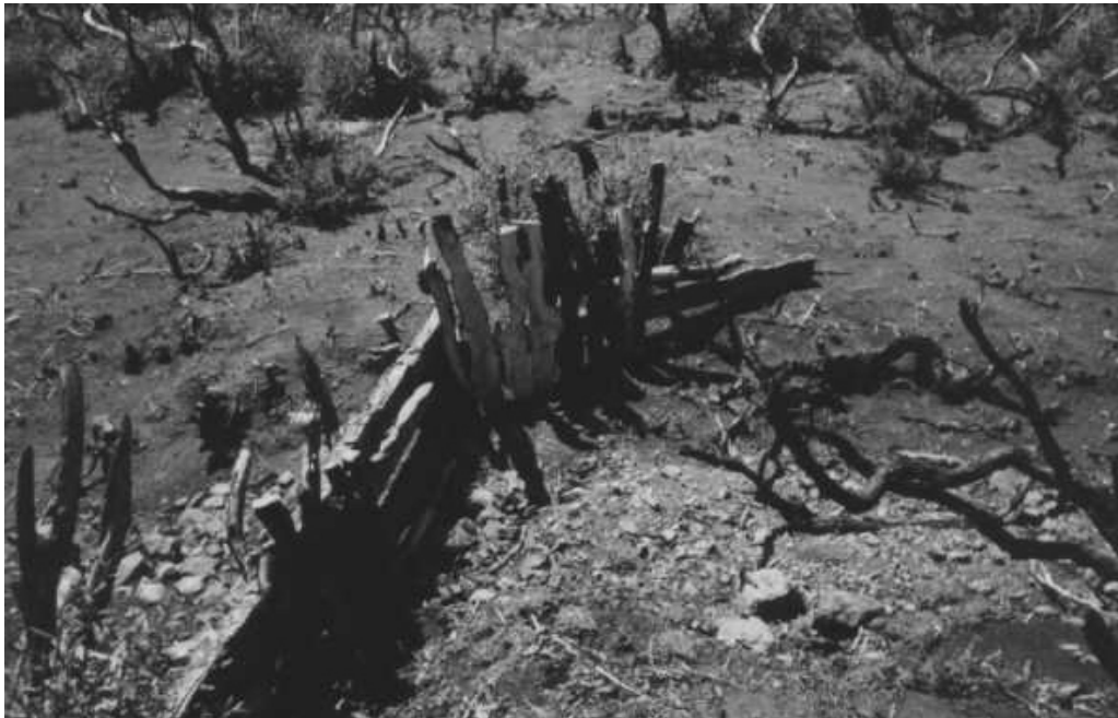
Figura 7.30. Tratamientos estructurales. Vista de aguas arriba de un dique de postes quemados.
