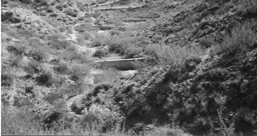
Figura 7.19. Azudes sobre canal de drenaje natural.
