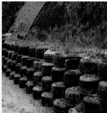
Figura 7.14. Estabilización de taludes con estructura de postes de madera - malla media sombra - neumáticos. Vargas et al. (1998).
