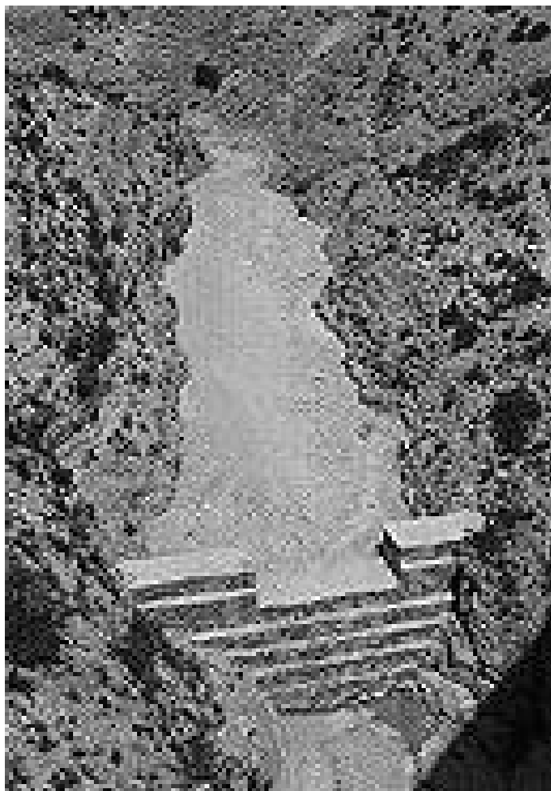
Figura 7.29. Detalle de un dique colmatado.
