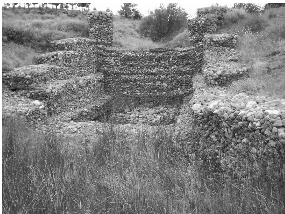
Figura 7.28. Tratamiento integral biológico y estructural en la zona cordillerana. Argentina. Detalle de un dique gavionado (2006).
