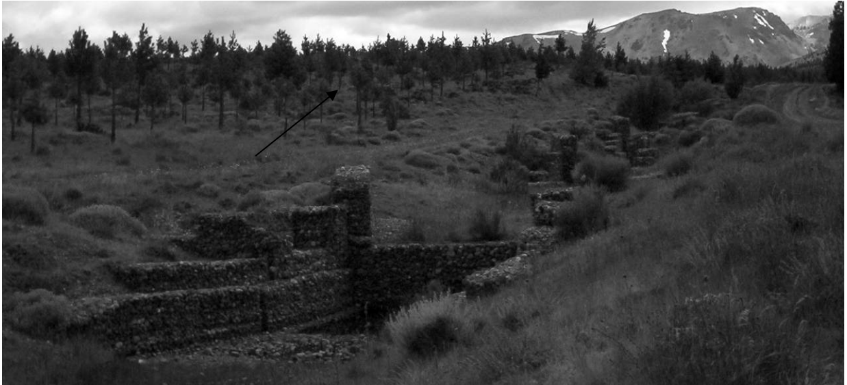
Figura 7.17. Tratamientos integrales biológicos y estructurales en la zona cordillerana. Argentina. (2006).
