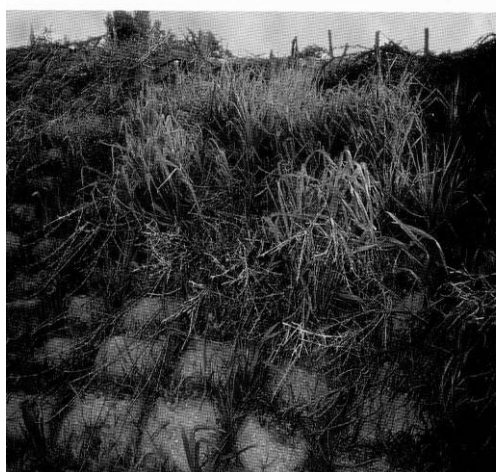
Figura 7.14. Estabilización de taludes con estructura de postes de madera - malla media sombra - neumáticos. Vargas et al. (1998).
