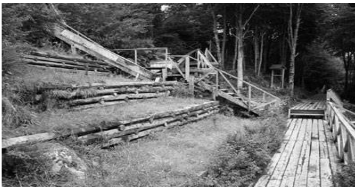
Figura 7.5. Obras longitudinales sobre laderas con pequeñas terrazas contenidas con postes, empastadas.
