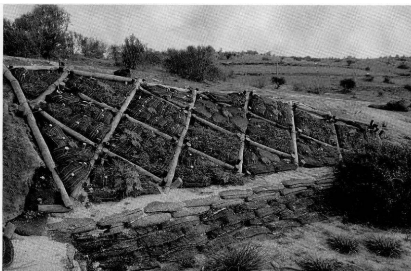
● Vista general de una estructura de postes de madera y sacos de malla de sombra para el control de erosión en taludes.
