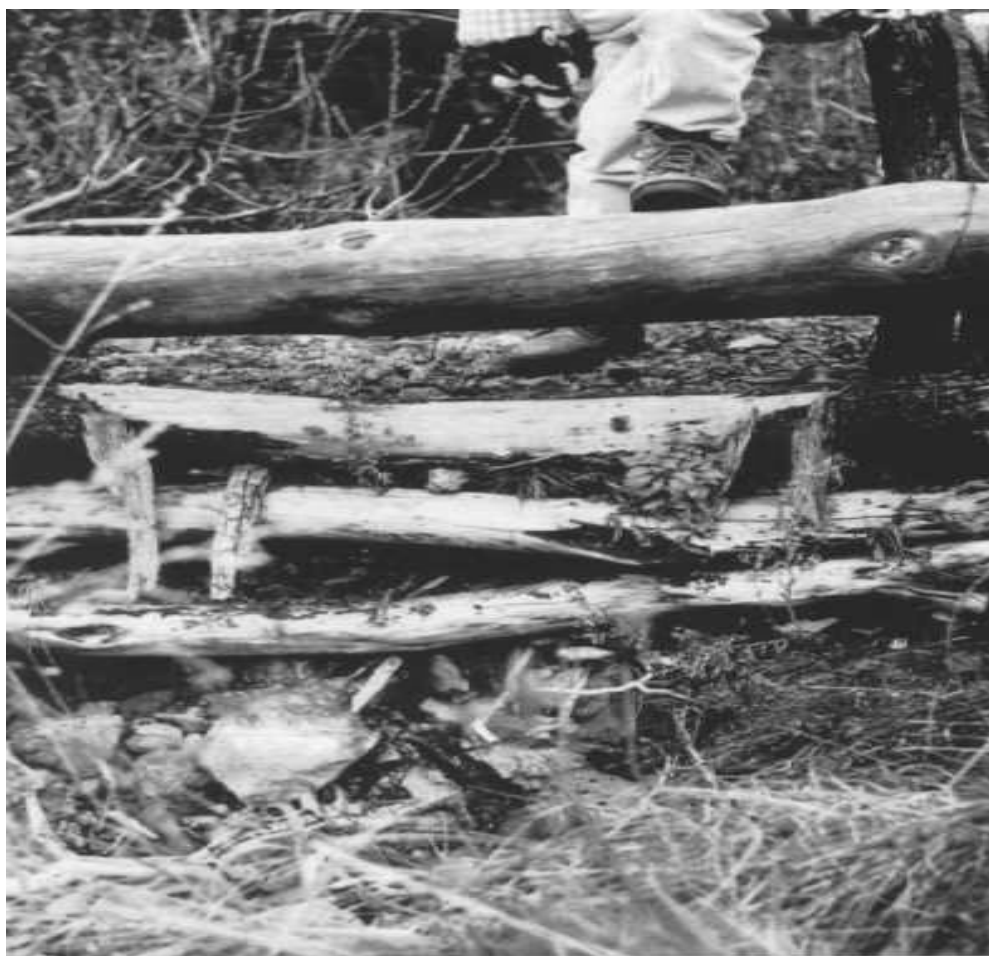
Figura 7.32. El mismo dique que la Figura 7.31, en estado de colmatación (Año 2005).
