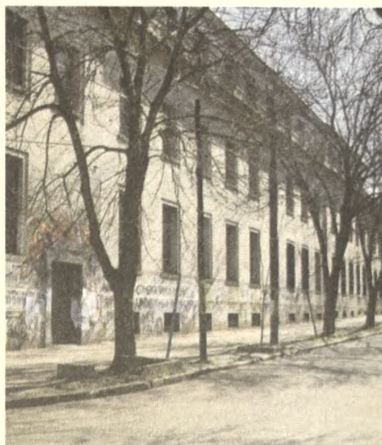
Bachillerato de Bellas Artes
