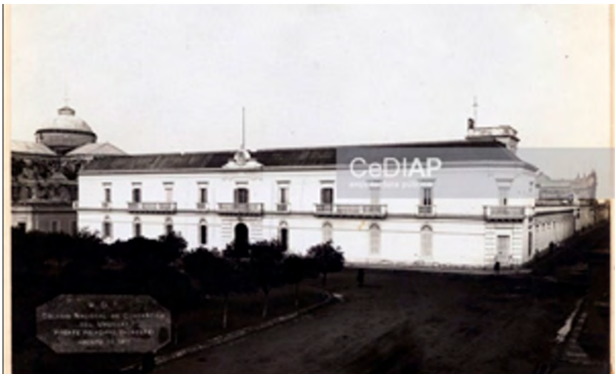
Figura 1: Colegio Nacional Justo José de Urquiza, frente principal (Noreste), Concepción del Uruguay, Entre Ríos. Fuente: MOP, archivo CeDIAP.
