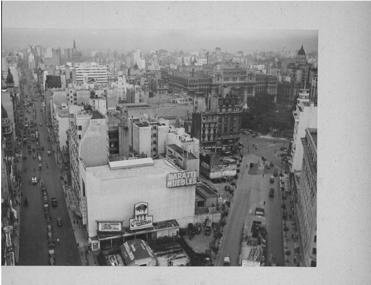
Figura 6: La imagen deja a la vista las medianeras desnudas y la cartelería publicitaria, asimismo, podemos ver las demoliciones y la transformación de la ciudad en las construcciones precarias que se ven al frente y la avenida aún no consolidada. Avenida Roque Saenz Peña. Carpeta 67, Inventario: 63469. AGN.
