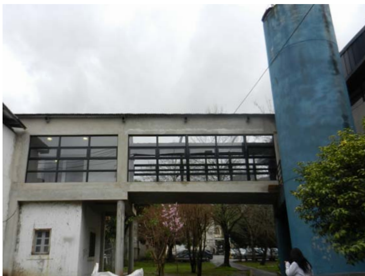
► Ampliación de laboratorios y construcción de puente.
