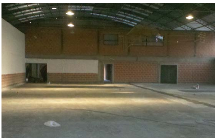
► Mudanza del LAIA y construcción de nuevas oficinas.
