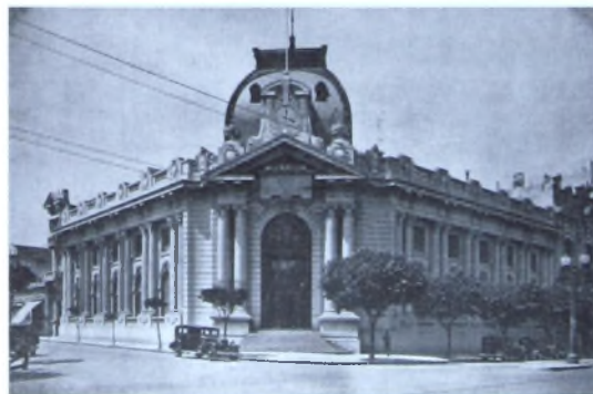
Fachada del Banco de la Nación Argentina
