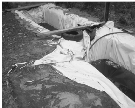
Fig. 4. Mini represa del agua de lluvia que escurre por el suelo
