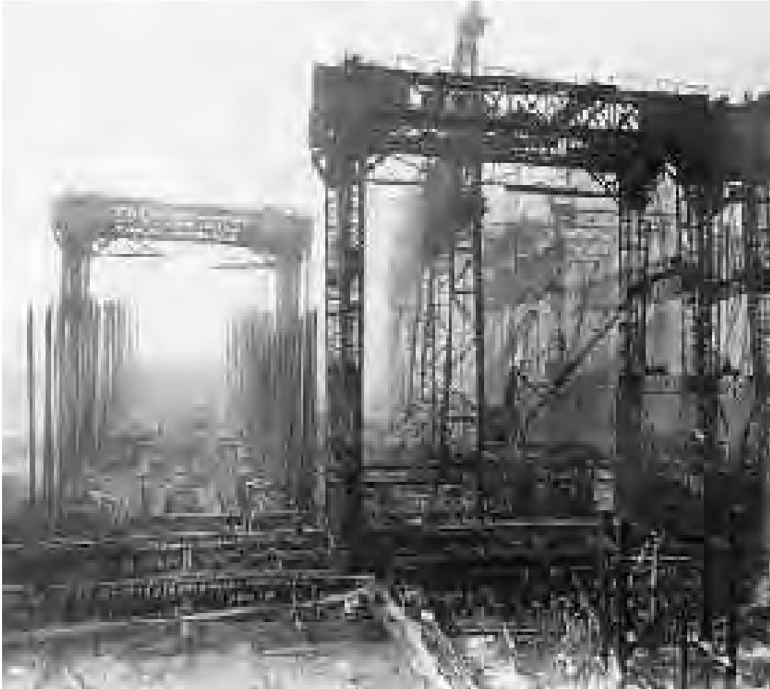
Foto N° 170 : En esta fotografía se puede apreciar la construcción de los “gantries” o caballetes, sobre los que se habrían de montar las estructuras de los tres gigantes barcos de la White Star Line, que habrían de llevar por nombre “Olympic”, “Titanic” y “Britannic”, en el astillero Harland & Wolff, de la ciudad de Belfast, Irlanda del Norte . -
