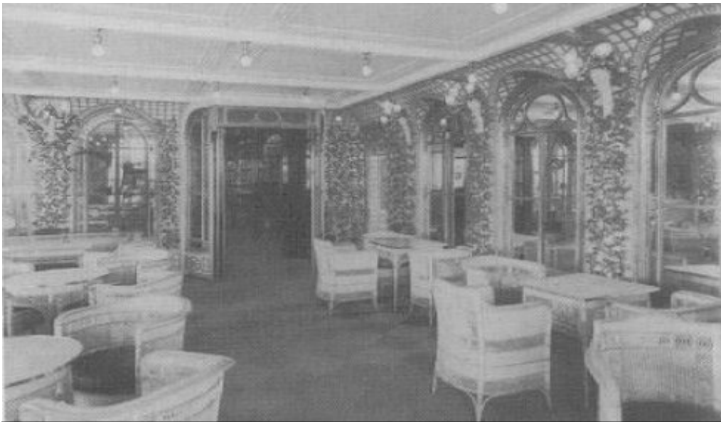
Foto N° 219 : Fotografía del Café Veranda .Nótense el buen gusto del ambiente, dado por sus sillas y mesas y el detalle de las hiedras sobre las paredes. enmarcando las ventanas .-
