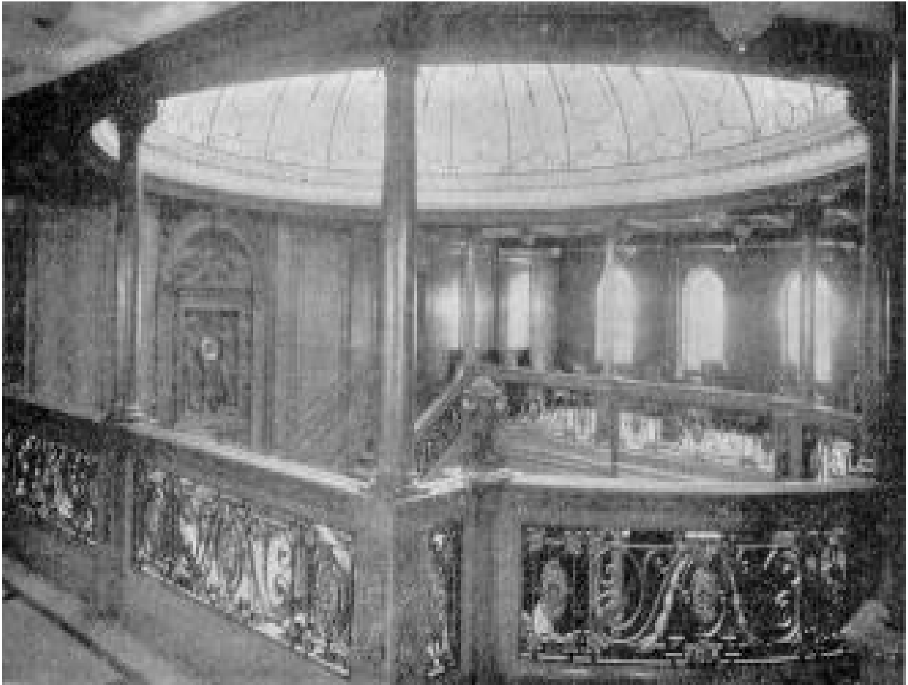
Foto N° 213 : Fotografía de la “Gran Cúpula” .En esta foto se puede advertir la hermosura del conjunto cúpula – escalera .Evidentemente , los artesanos encargados de este trabajo , supieron hacerlo muy bien .La foto presenta una claridad manifiesta , pero evidentemente se procuró tomar la vista en un día soleado ( y posiblemente , a mediodía ) , de manera de resaltar la luminosidad del conjunto. Para no faltar a la verdad, la foto es, en algunos aspectos, difusa : es de hacer constar que por más que las nuevas cámaras fotográficas se estaban desarrollando “ a todo vapor”, todavía faltaba mucho camino para llegar a las películas con filtros solares y demás progresos .Pero así y todo, la foto es una buena muestra de lo que los pasajeros de 1ra.clase del RMS “Titanic” podían tener ante su contemplación .Comentemos que , aunque la luminosidad es quizás demasiada, lo que intentó el fotógrafo, al tomar la foto, es resaltar también el brillo del roble pulido y el trabajo de herrería (forjado) entre balaustradas .-
