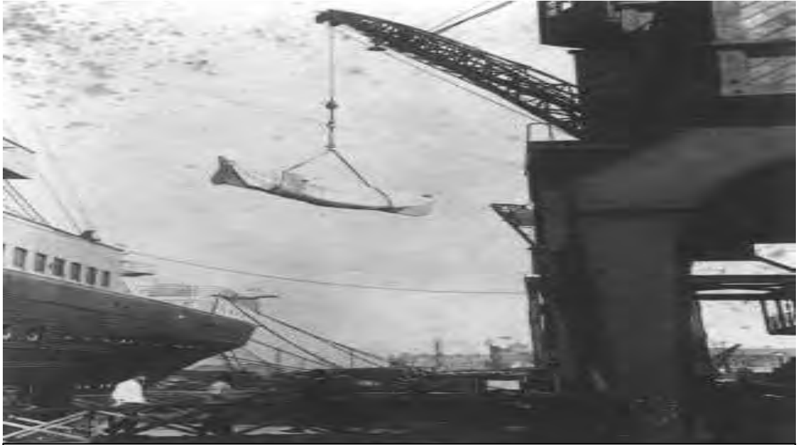
Foto N° 180 : Bote salvavidas izado sobre la cubierta del RMS "Titanic", por la grúa portable de 250 toneladas .-
