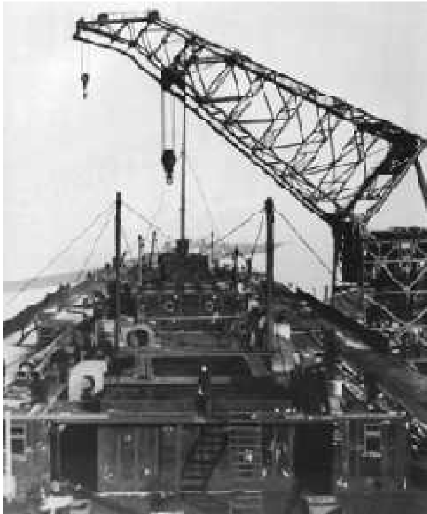
Foto N° 171 : Fotografía de la grúa portable, cuya capacidad de izado era de 250 toneladas (250 mil kilos) . En esta misma foto , se aprecia al “Titanic” durante el proceso de armado externo . -
