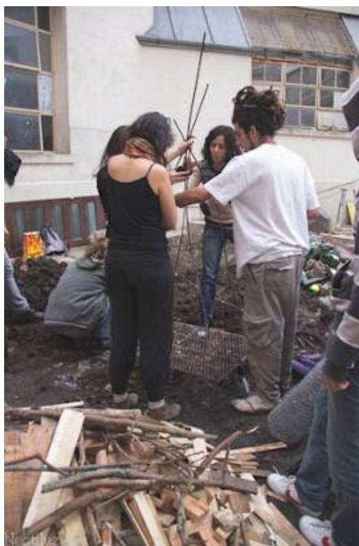
Comienzo de la estructura, CTCC 2013 (foto Lola Boffo).
