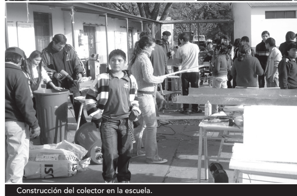
Construcción del colector en la escuela.
