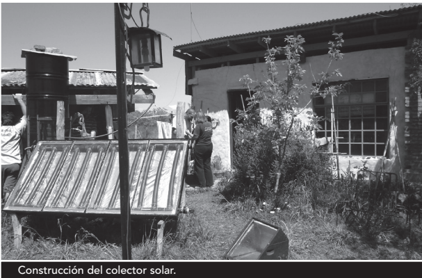
Construcción del colector solar.
