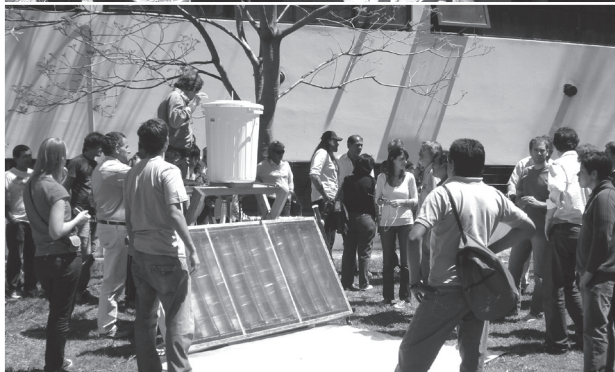
Construcción e instalación del colector en la FAU.
