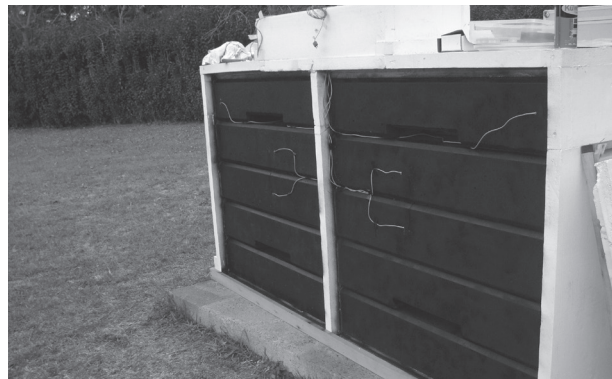
Muro MAC premoldeado de hormigón y hormigón + agua (IIPAC-LAMbDA). 2011
