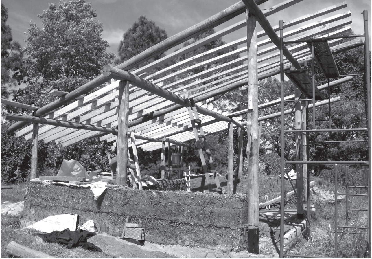
Construcción en CEDEPO. La Carolina, Florencio Varela.
