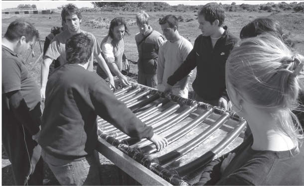
Construcción del colector solar.
