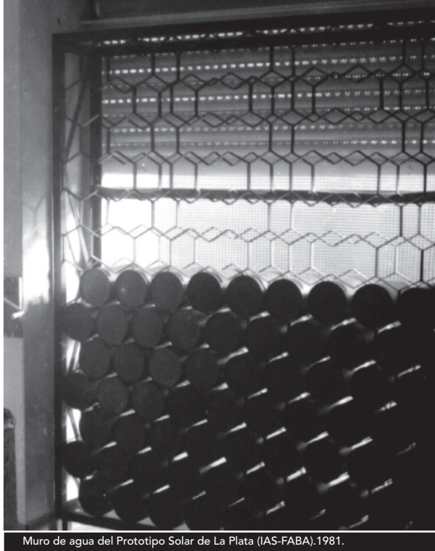
Muro de agua del Prototipo Solar de La Plata (IAS-FABA). 1981.
