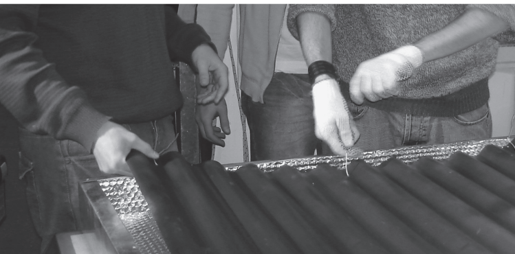
P1. Chapa ondulada de zinc.
