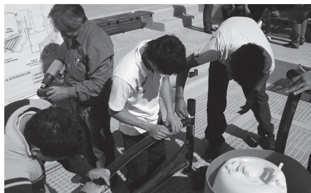
Construcción del colector en una escuela.
