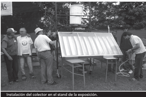
Instalación del colector en el stand de la exposición.
