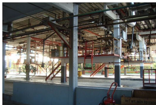
Figura 2 – Fotografía del cargadero de camiones.
