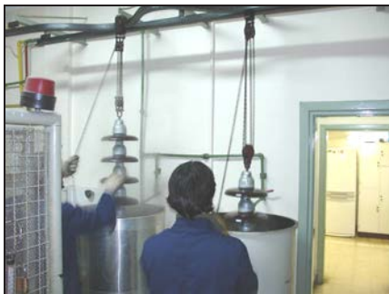
Foto 8. Inmersión de aisladores en los baños
