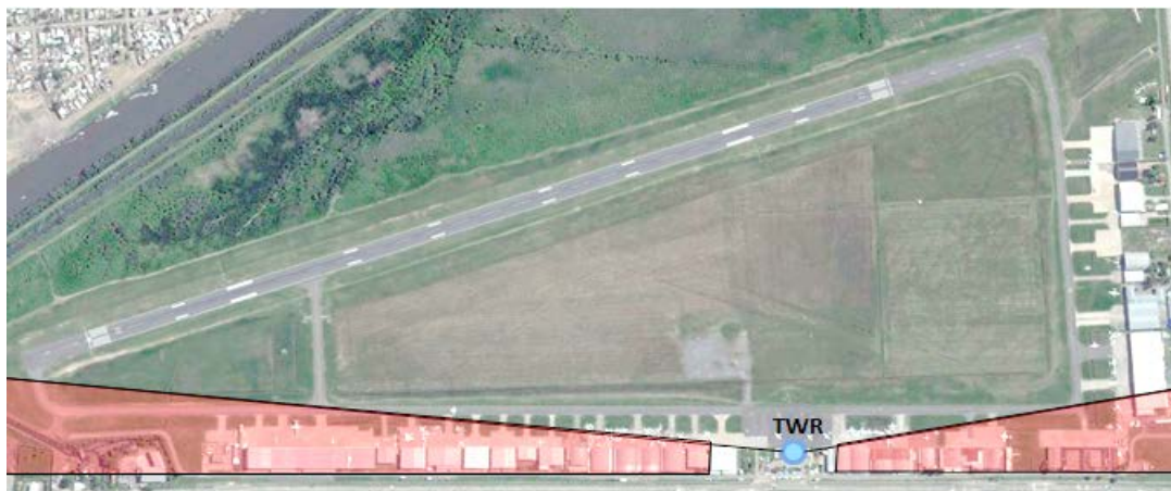
Figura 5– Zona de sombra en plataformas y calles de rodaje Aeropuerto Internacional de San Fernando.
