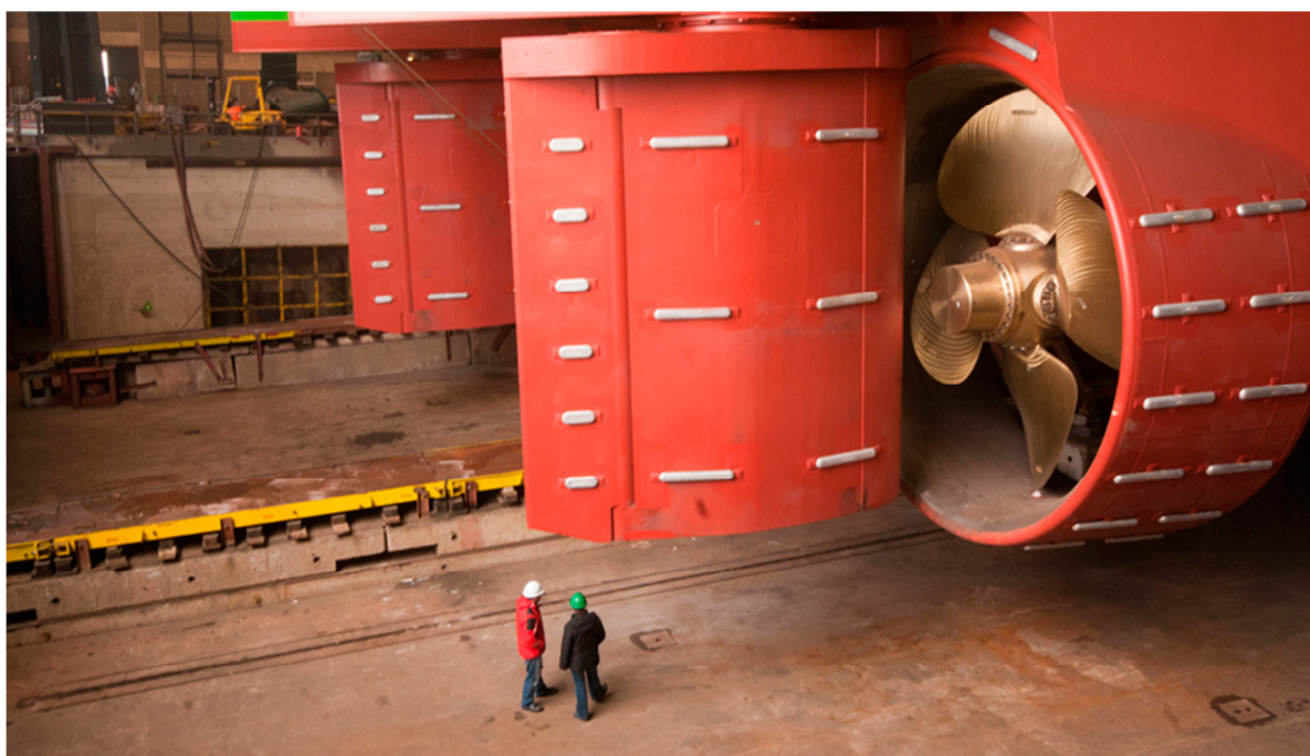
Figura 10.14. Casco de un barco con parches grises de Zn que actúa como ánodo de sacrificio para evitar la corrosión. Foto: gentileza de Socomet Chile ( http://www.socometsa.com ).
