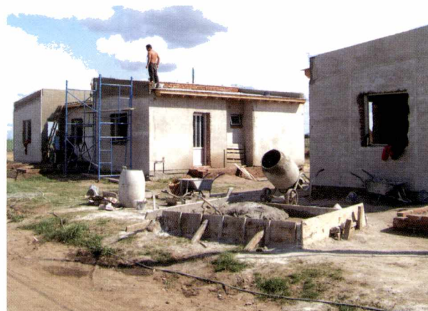
CONSTRUCCIÓN DE VIVIENDAS. FOTO DANIEL ALACIO
