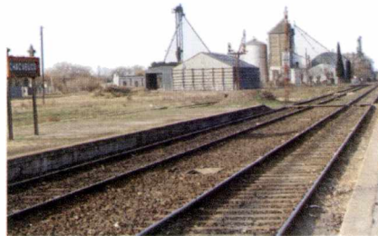
ESTACIÓN DE TREN DE CHACABUCO. FOTO DAM, UNLP
