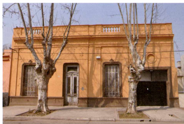
FACHADA EN REMODELACIÓN DEL AULA CHACABUCO FRSN-UTN UBICADA EN CALLE RE- MEDIOS ESCALADA DE SAN MARTIN 138. FOTO PABLO VILLANUEVA
