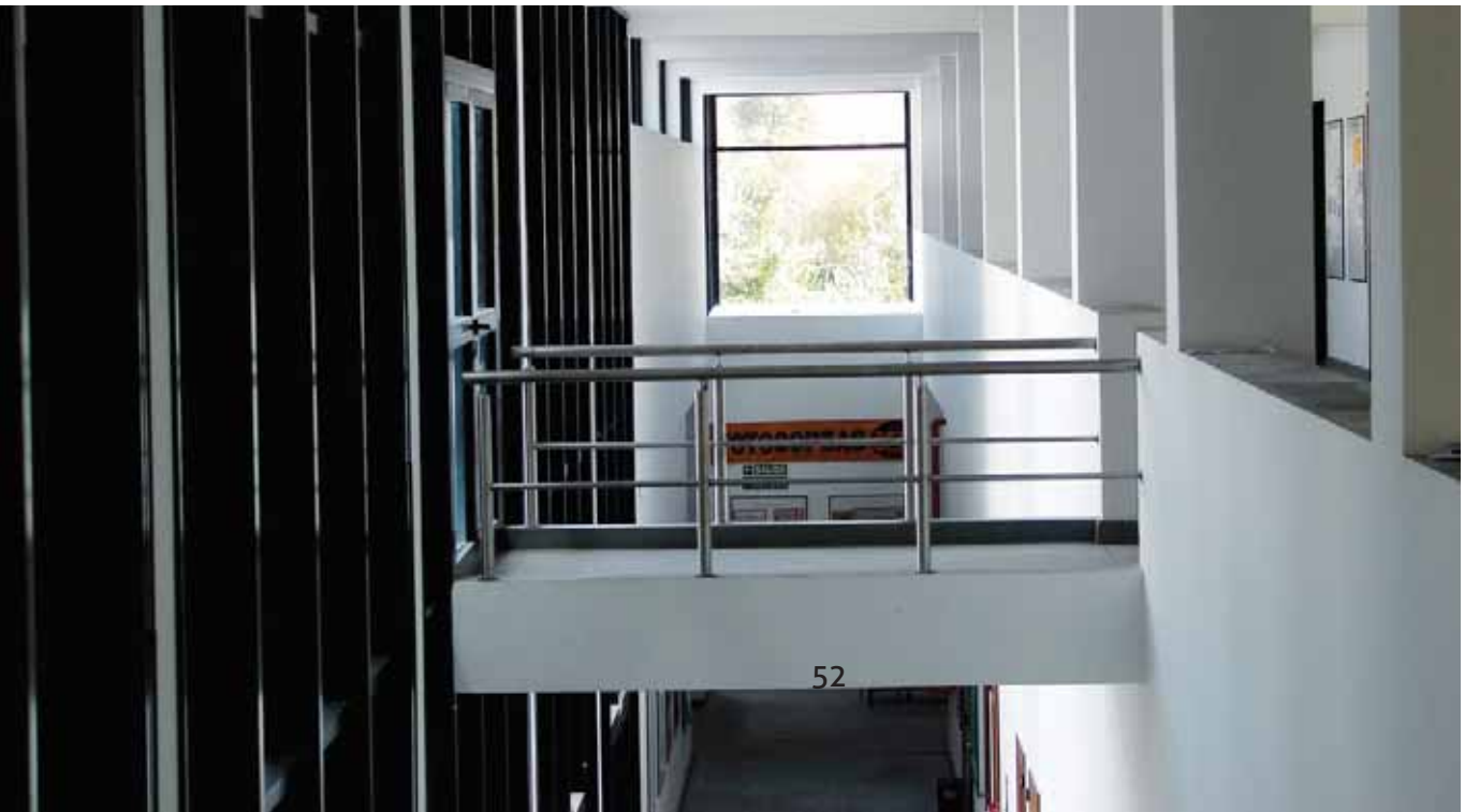
▼ Detalle de pasillo interior
