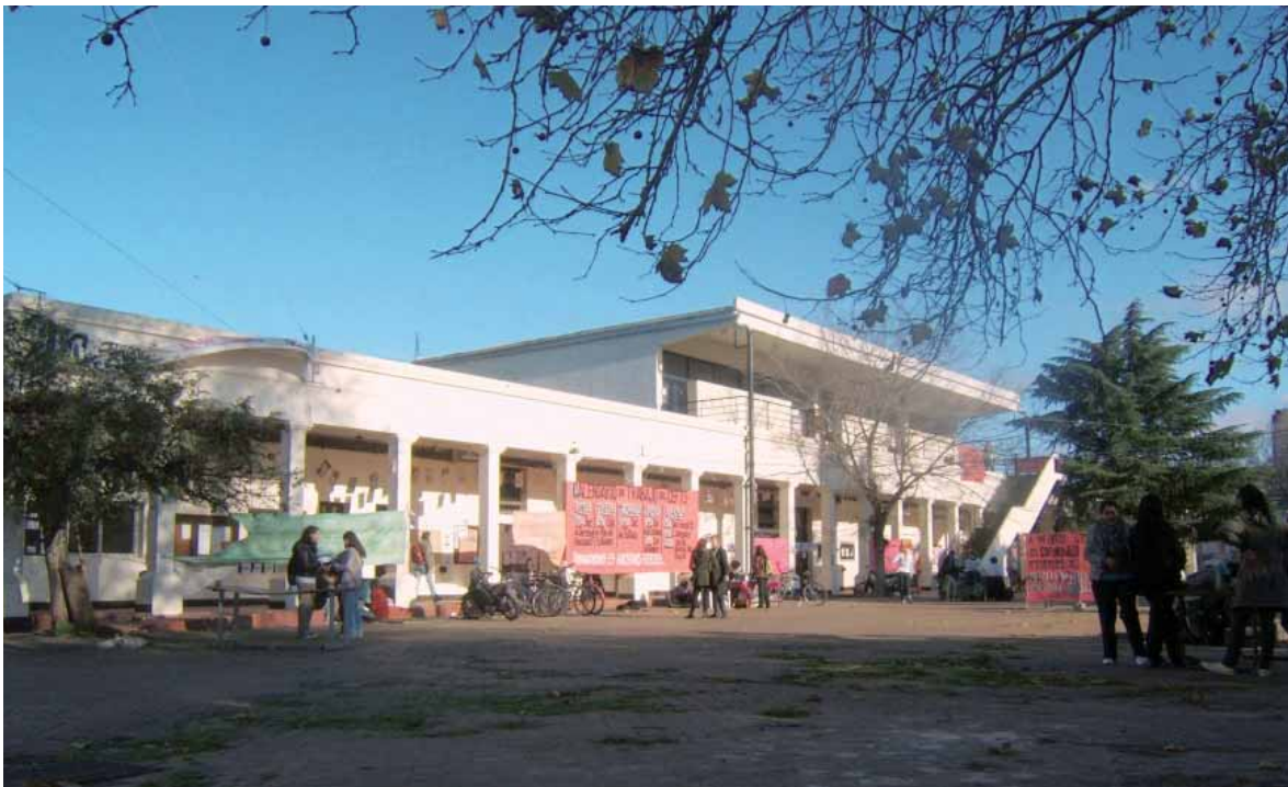
▼ Vista patio interior - Etapas 1 y 2
