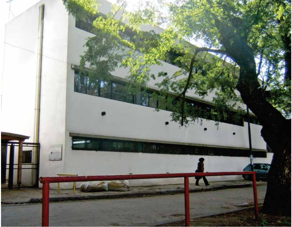
▲ Vista hacia calle 48 - Nuevo pabellón de aulas
