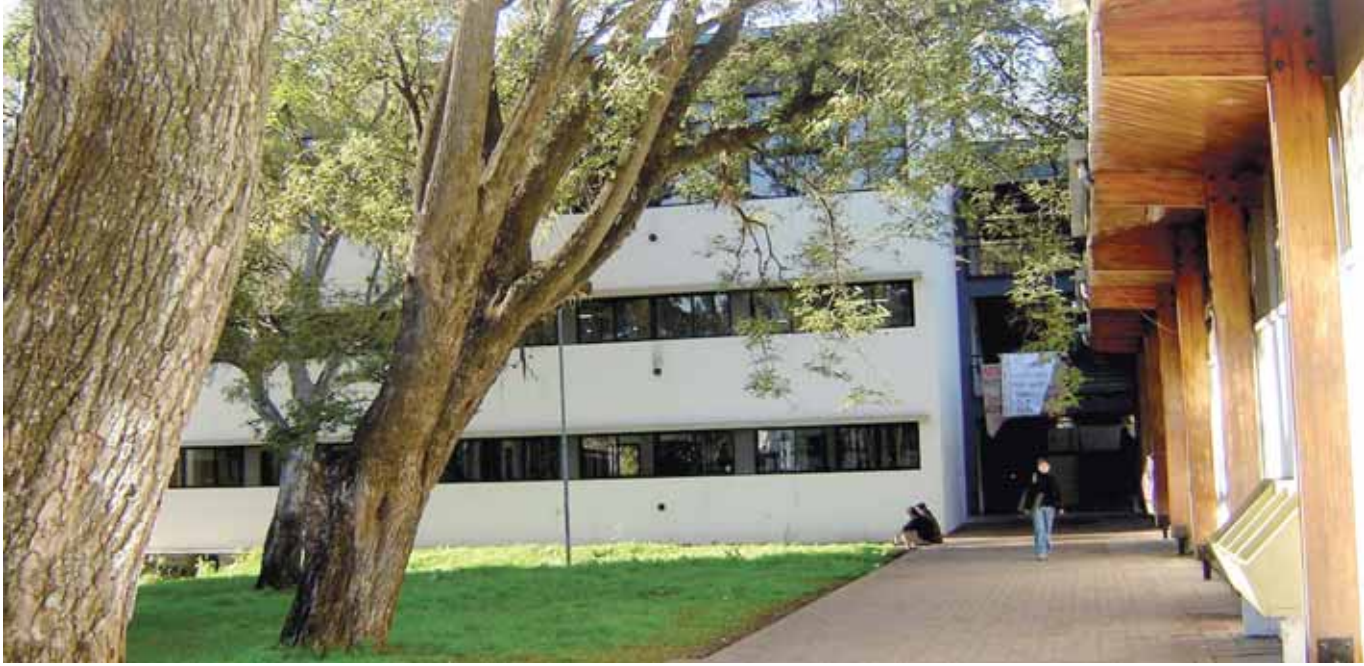
▲ Nuevo pabellón de aulas - Vista interior
