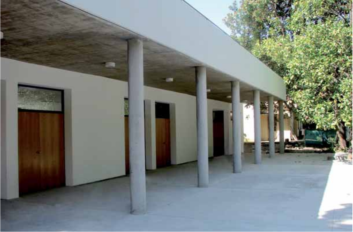
▲ Vista de aulas desde patio
