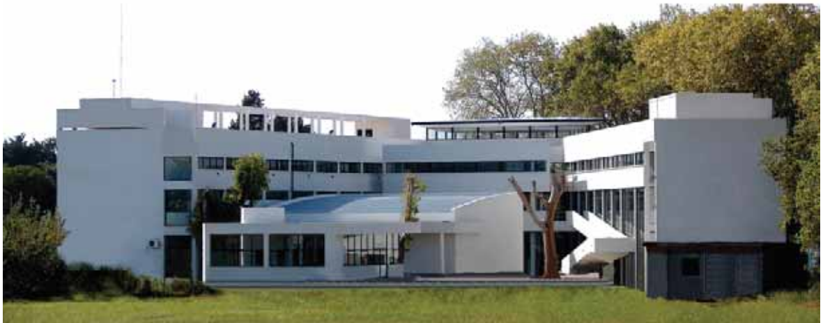
▲ Vista desde Escuela Anexa Etapa 1
