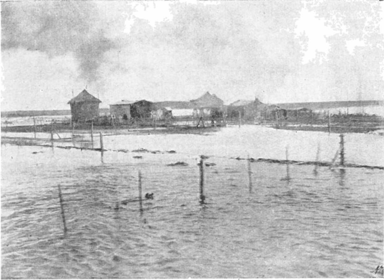
Ranchos de la chacra del Sr. Piacentini, Saladillo, sobre el ramal á San Enrique, Km. 193 F. C. Sud. el 19/7/1919, 20 cms. más bajo que el máximo de aguas
