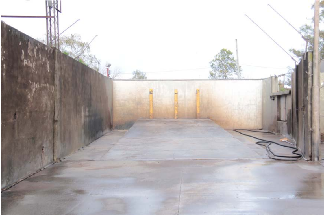
Foto 34. Paredes de mampostería de 3 metros de alto como mínimo. Los caños que están por sobre la pared e inclinados hacia adentro, se utilizan para la desinfección del transporte con una solución de carbonato de sodio al 4%.
