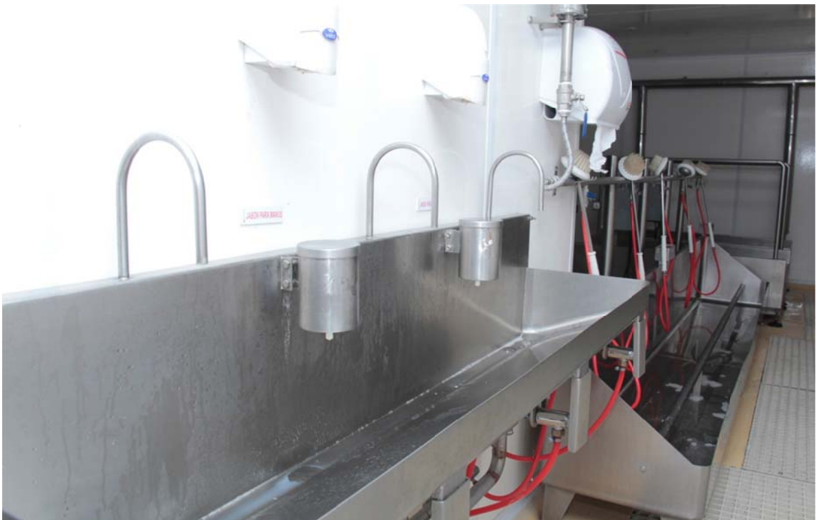
Foto 11. Filtro de entrada a despostada. Se observa el lavamanos, lavabotas y en el fondo el lavasuelas.
